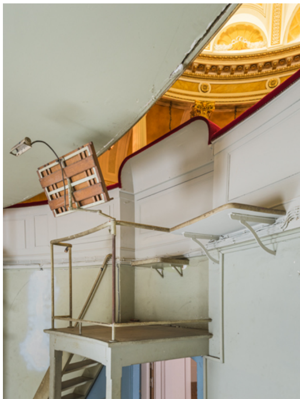
Sous-sol, salle du jeu d'orgue : estrade du chef d'orchestre (vue rapprochée). 71, Le Creusot rue Jules Guesde
