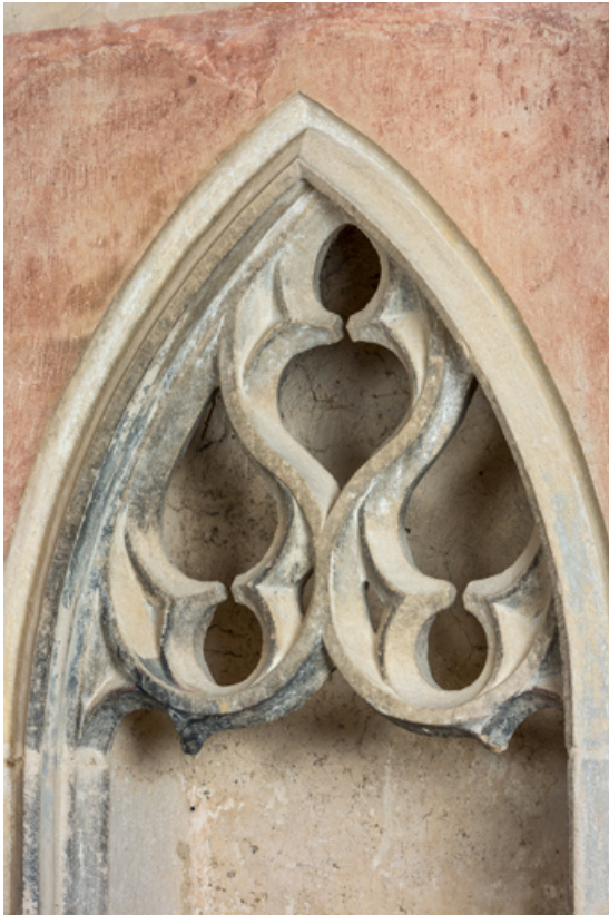
Détail : remplage de la partie supérieure.
