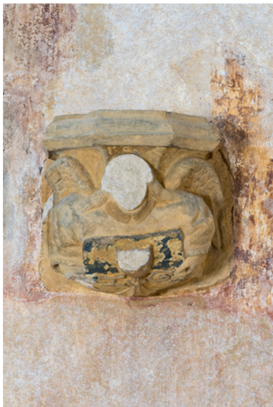
Mur nord, culot de droite : ange porteur d'écu.
