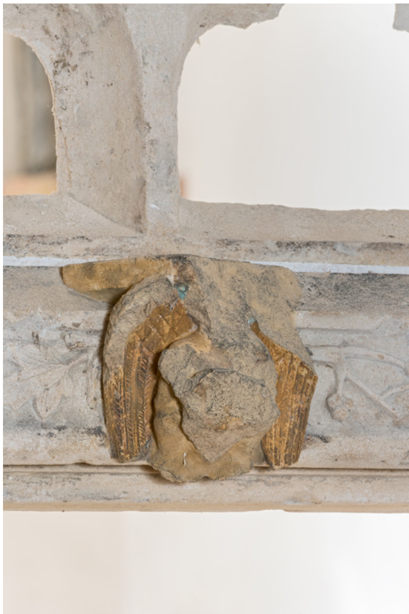
Détail : ange porteur d'écu du linteau.
