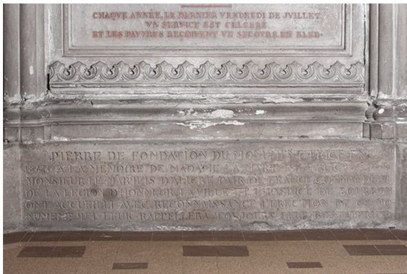
Détail : soubassement de la travée centrale.
