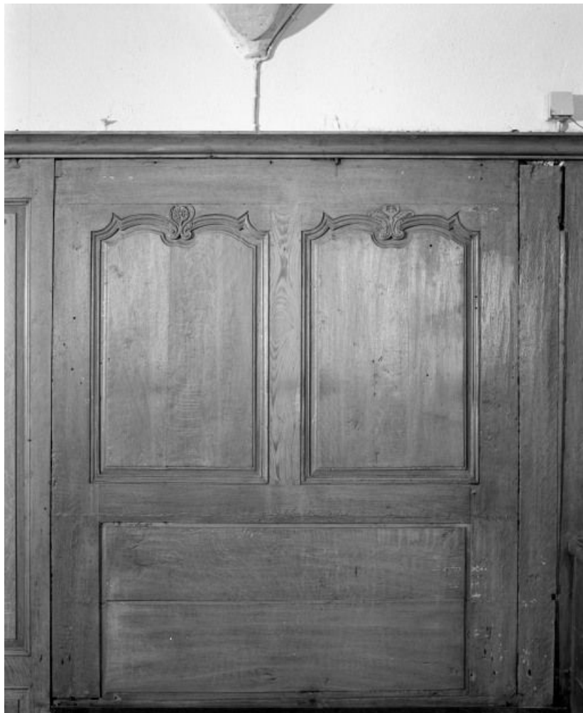
Lambris de demi-revêtement : panneaux à gauche de la porte de la sacristie. 71, Charnay-lès-Chalon Forge
