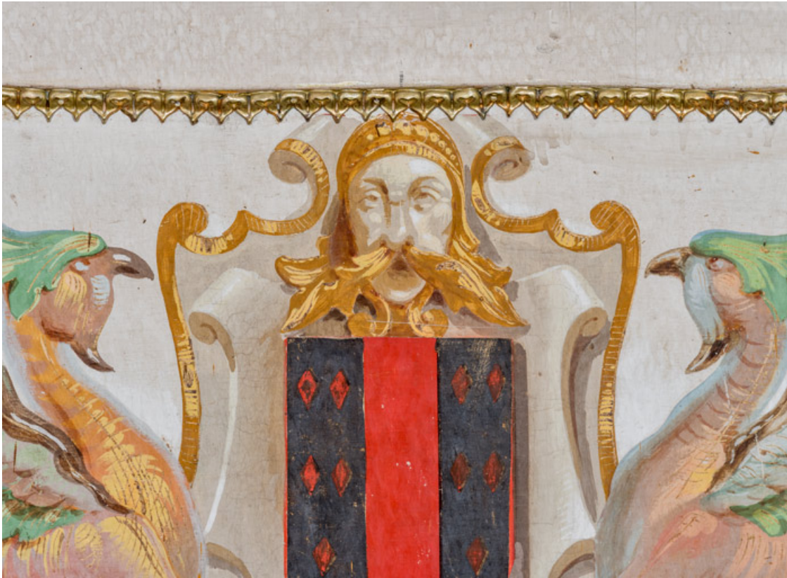
Garde-corps : armoiries de la famille de Frottier de la Coste (détail). 71, Palignes, lieudit : Digoine
