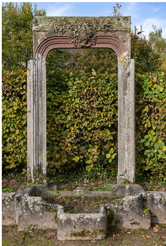
Encadrement de porte, vue de face.
