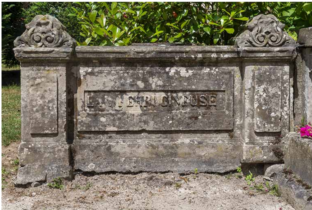
Inscription de l'une des deux fontaines latérales à l'entrée du Bain ferrugineux ("eau ferrugineuse"). 70, Luxeuil-les-Bains, 3 rue des Thermes
