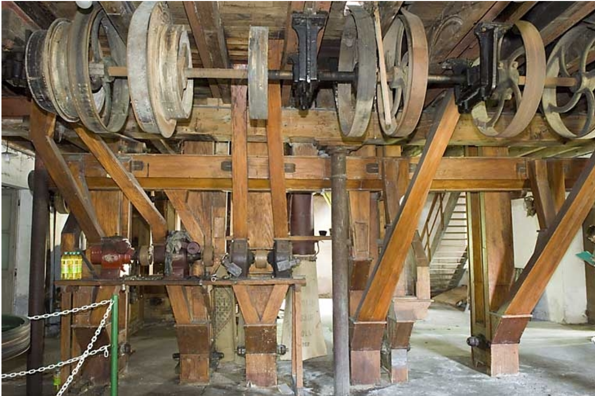
Rez-de-chaussée. Système de transmission et de circulation du blé par élévateurs à godets.
