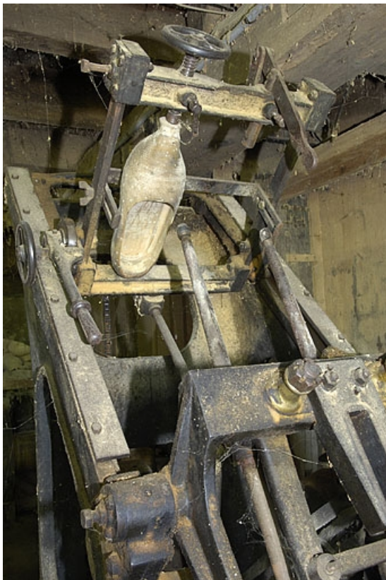
Rez-de-chaussée. Tour à cuillères (videuse) Bonneau & Schwartz et Cie. Détail de la partie supérieure. 70, Sainte-Marie-en-Chanois, lieudit : sur le Breuchin
