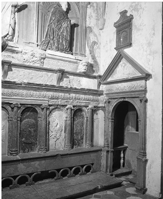
Façade ouest de la chapelle.
