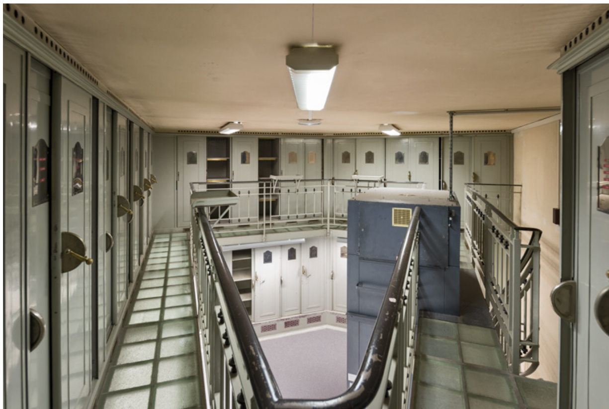
Caisse auxiliaire, armoires, coursives à garde-corps doté de tablettes mobiles. 58, Nevers, 6B rue Jean Desveaux
