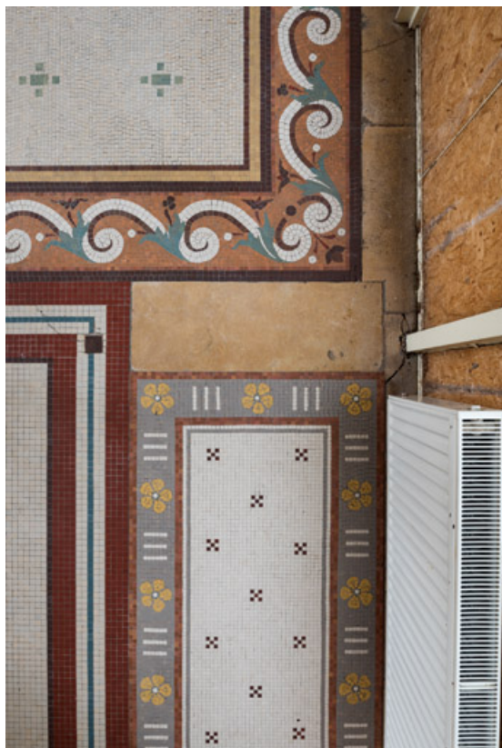
Seuil du couloir de jonction entre la villa (en bas) et le jardin d'hiver (en haut) avec l'agrandissement des années 1930-1940 (à gauche).
