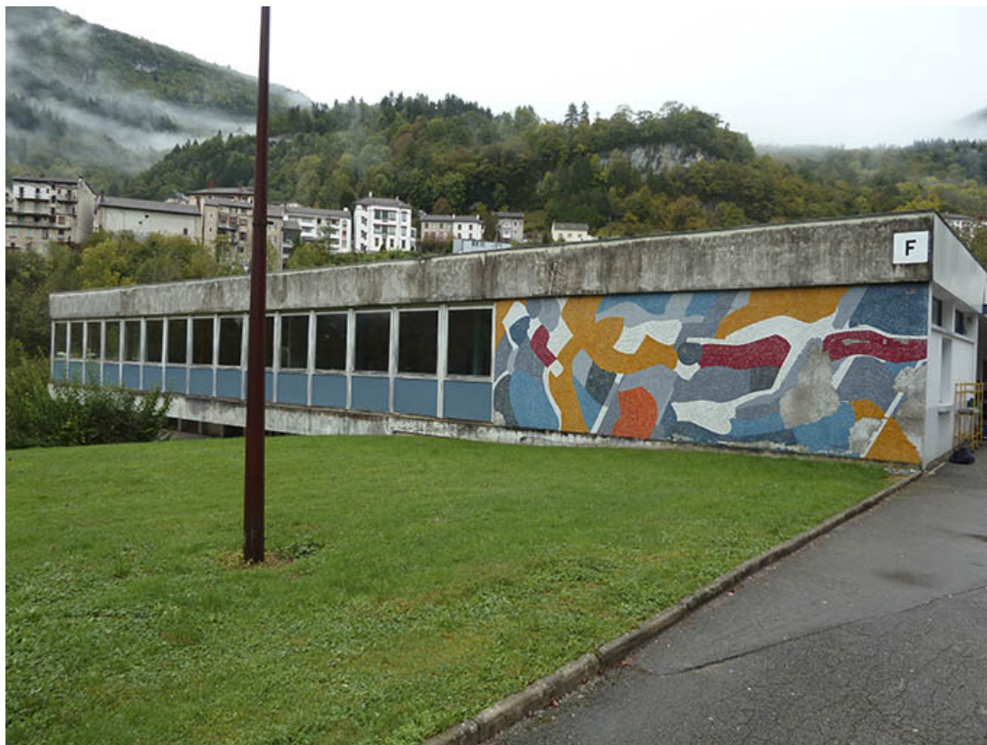
Le ski de fond : vue générale avant restauration du bâtiment.
