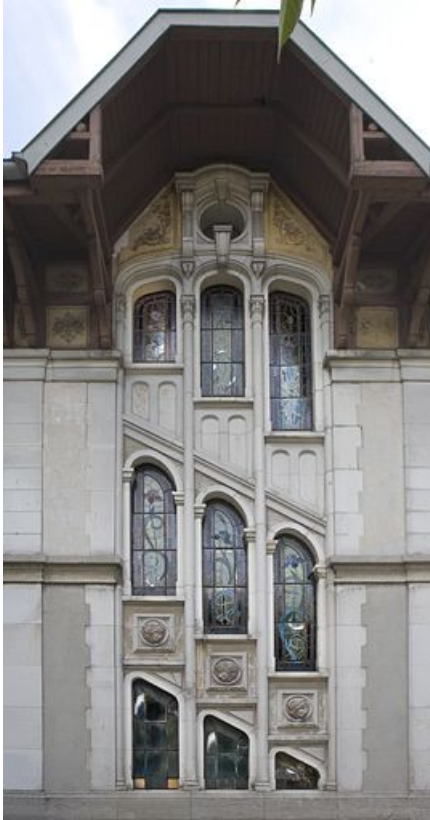
Vue d'ensemble, depuis l'extérieur.
