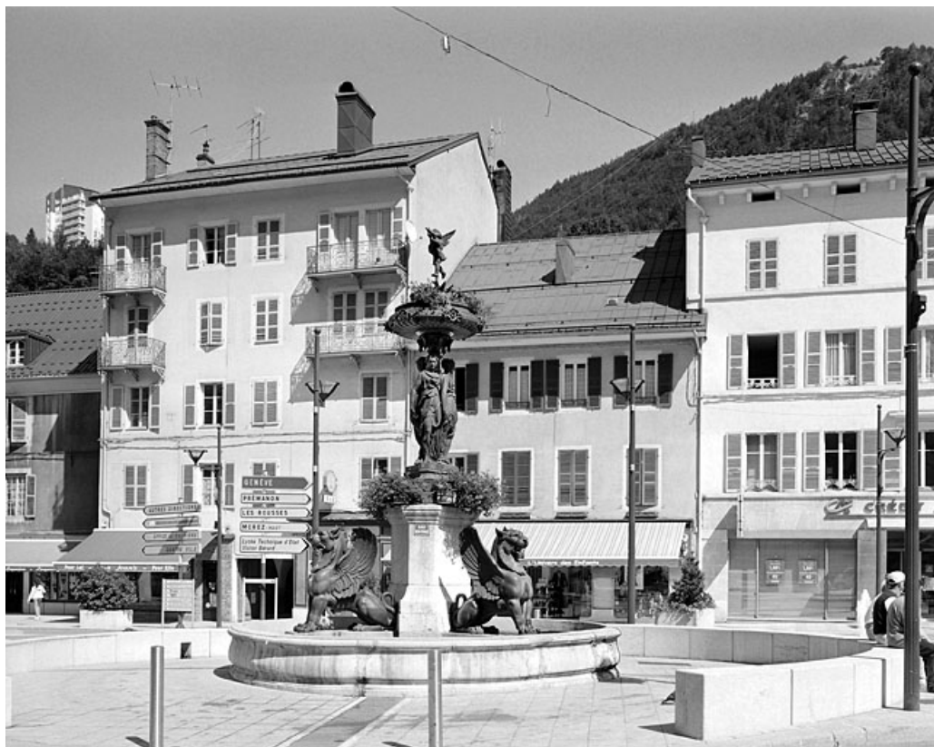
Vue d'ensemble de la fontaine et des statues.
