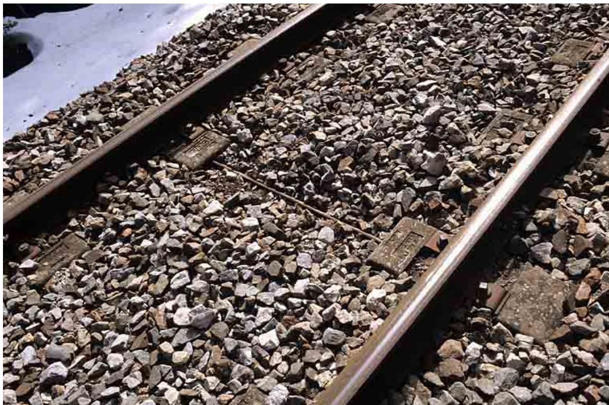
Vue plongeante sur une traverse Sateba, à proximité du pont sur la R.D. 18 (PK 045.208), commune de Morbier. in, Jura
