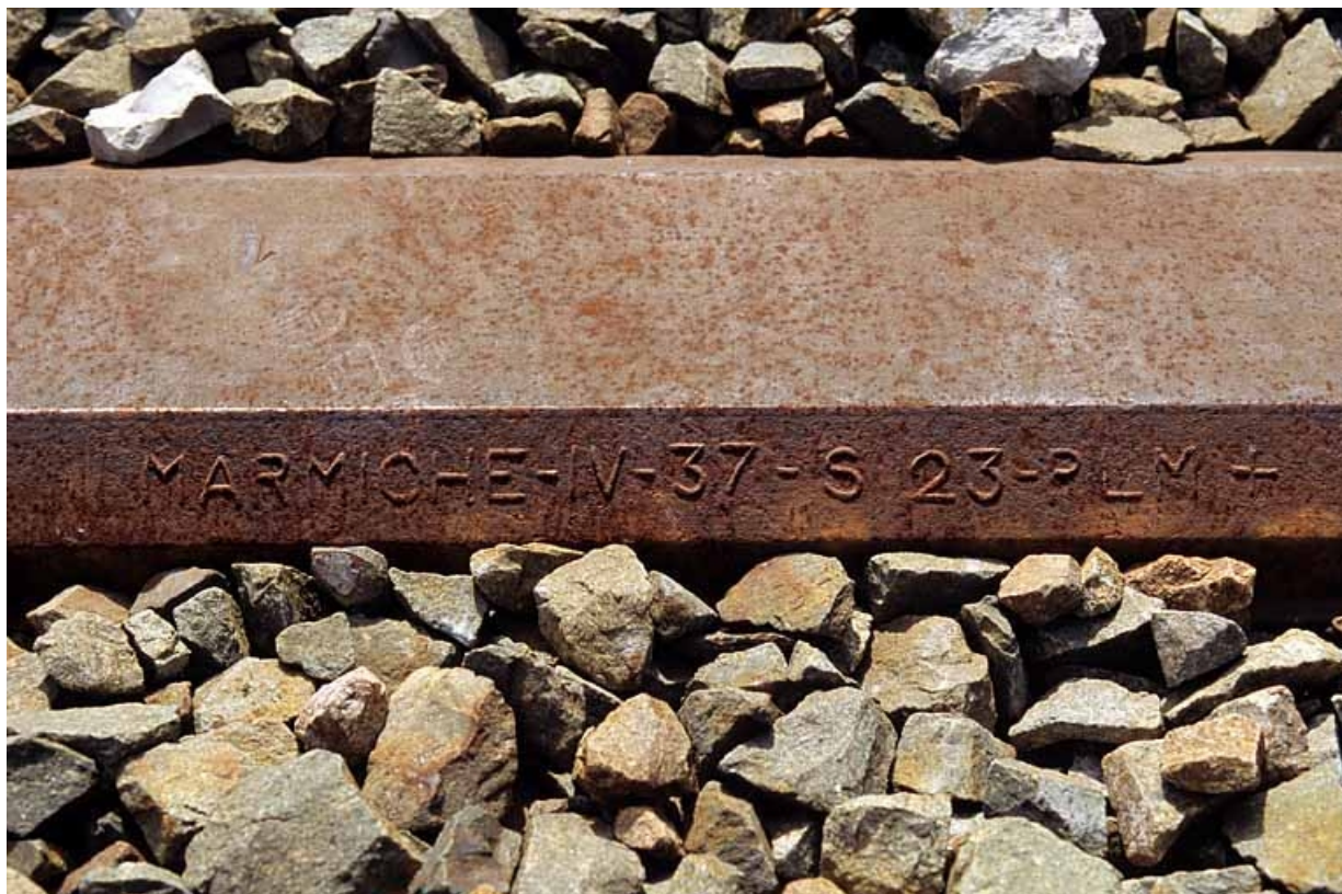
Inscription sur une traverse simple : Marmiche. Cette traverse est en place près du point kilométrique 042.500, entre le tunnel de la Savine et le passage à niveau n° 33 (commune de Morbier, Jura). in, Jura
