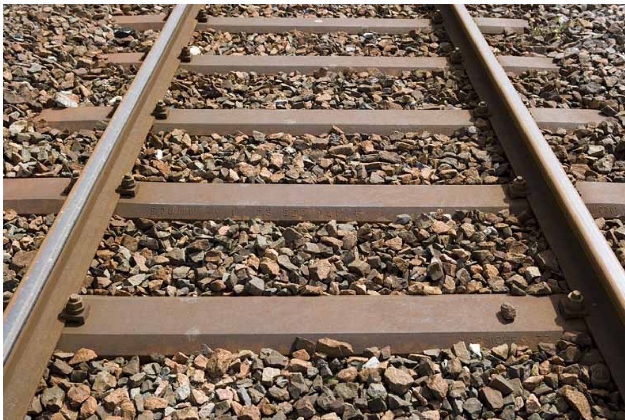
Traverses métalliques simples près du point kilométrique 012.000 (commune de Champagnole) : Stumm. in, Jura
