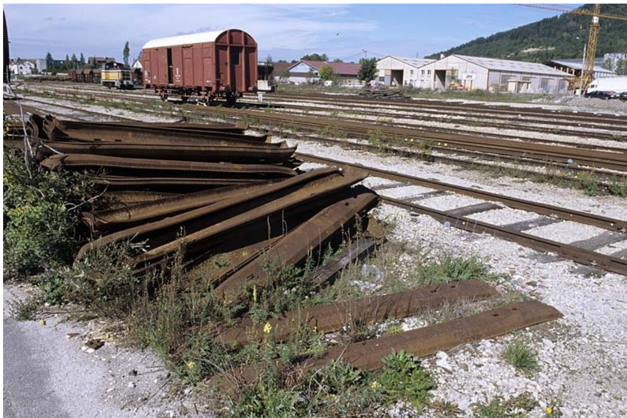
Traverses métalliques réformées stockées en gare de Champagnole. in, Jura
