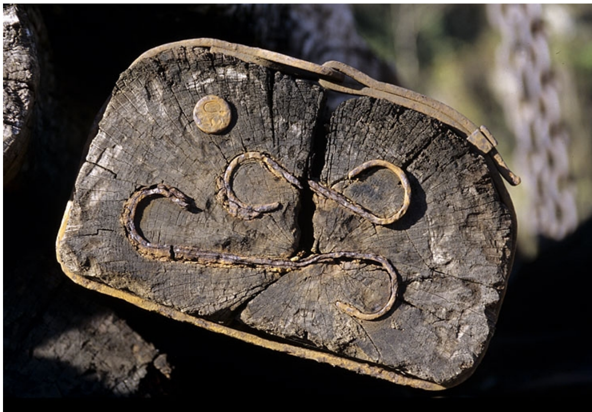
Extrémité d'une traverse avec frettage Delor, esses et clou. in, Jura
