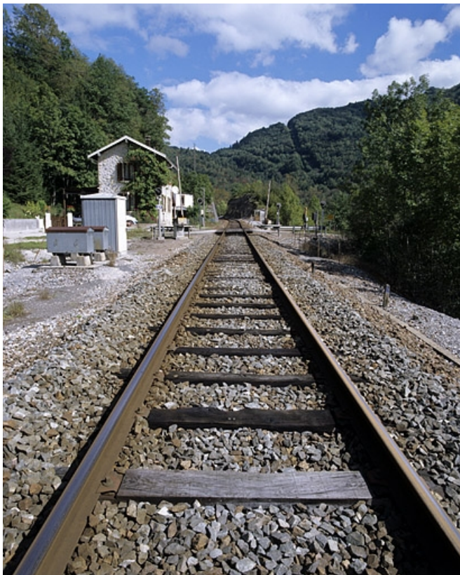
Exemple de voie avec traverses en bois. Voie ferrée au point kilométrique 070.700, en aval du passage à niveau n° 54 (commune de Saint-Claude).
