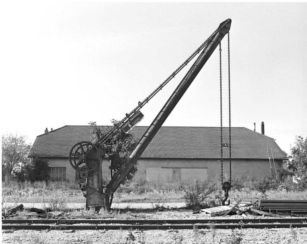
Vue d'ensemble de profil, depuis le nord-est.
