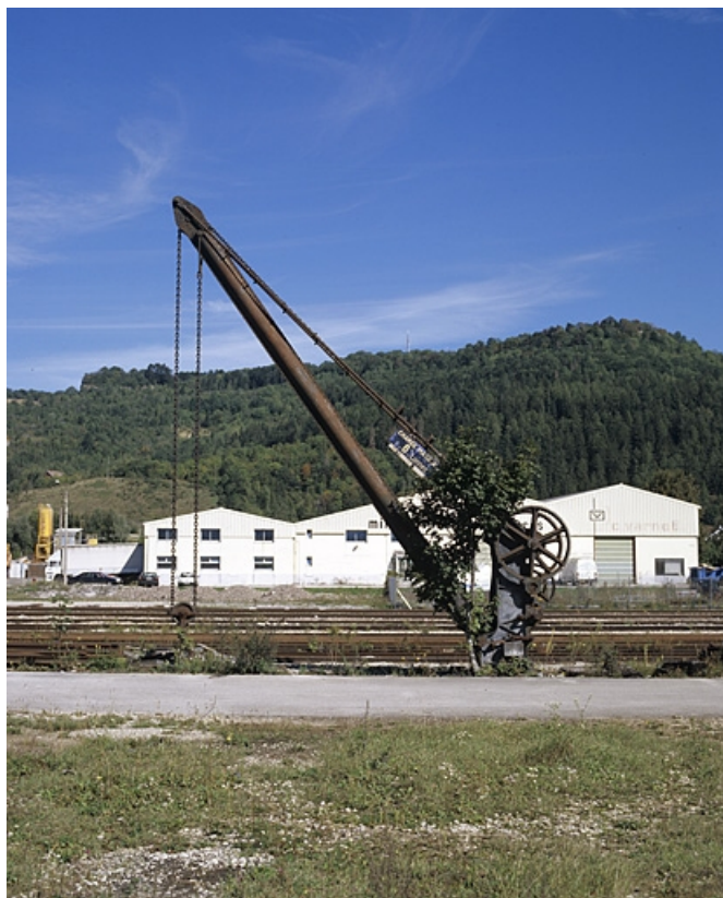
Vue d'ensemble de profil, depuis le sud-ouest.
