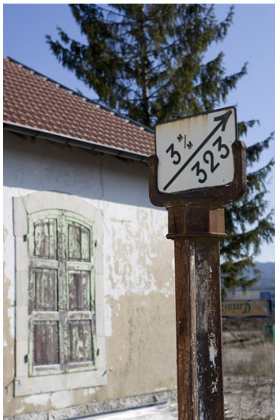
Face côté Andelot-en-Montagne. Le panneau signale que la voie est en rampe (pente ascendante) de 3 mm / m sur 323 m. 39, Champagnole, 13 avenue de la Gare
