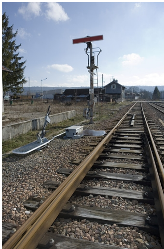
Vue d'ensemble, depuis le côté Andelot-en-Montagne.
