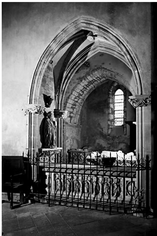
Vue générale depuis le chœur.
