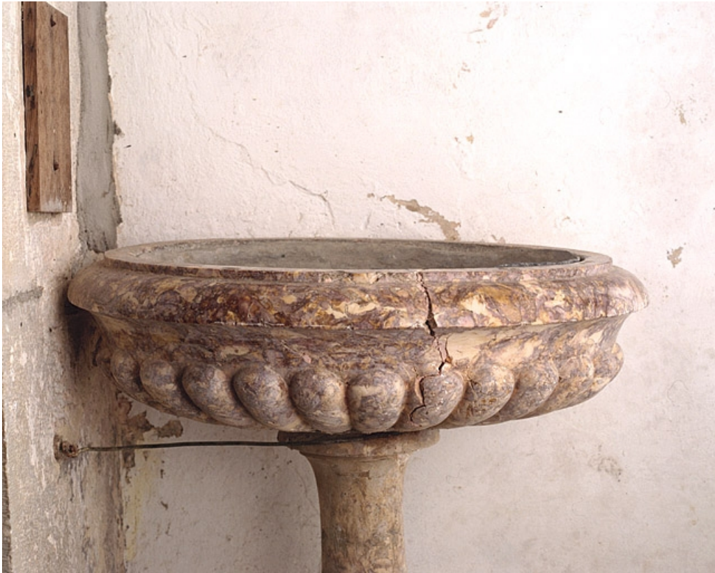
Détail de la cuve.
