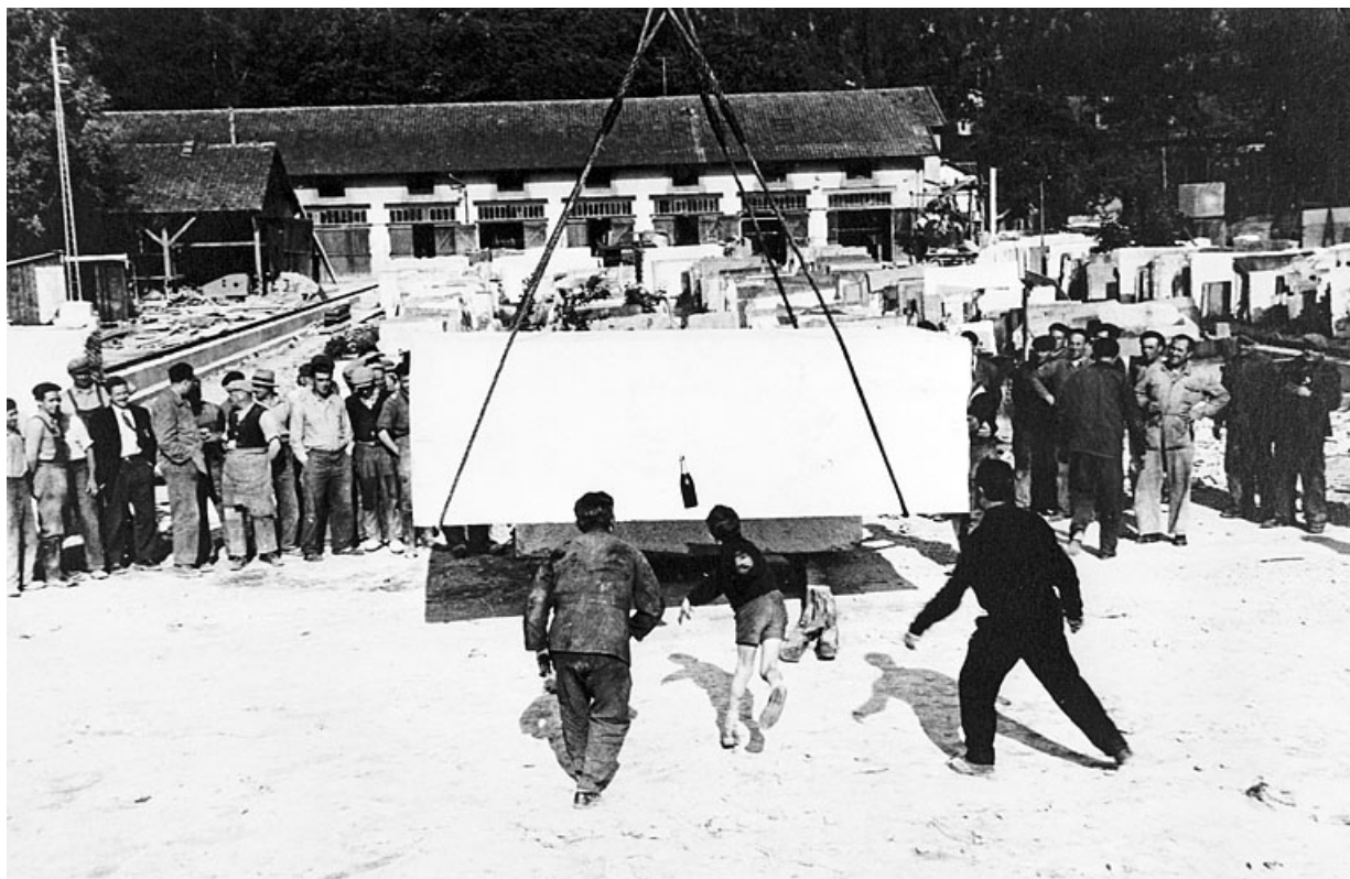
Inauguration : baptême du portique roulant.
