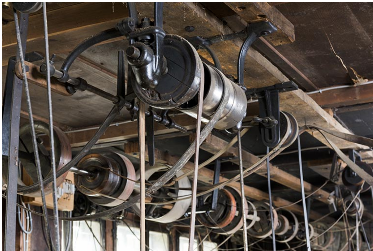
Arbre de transmission secondaire de la rangée centrale (au premier plan) et arbre principal (à l'arrière-plan). 25, Les Gras
