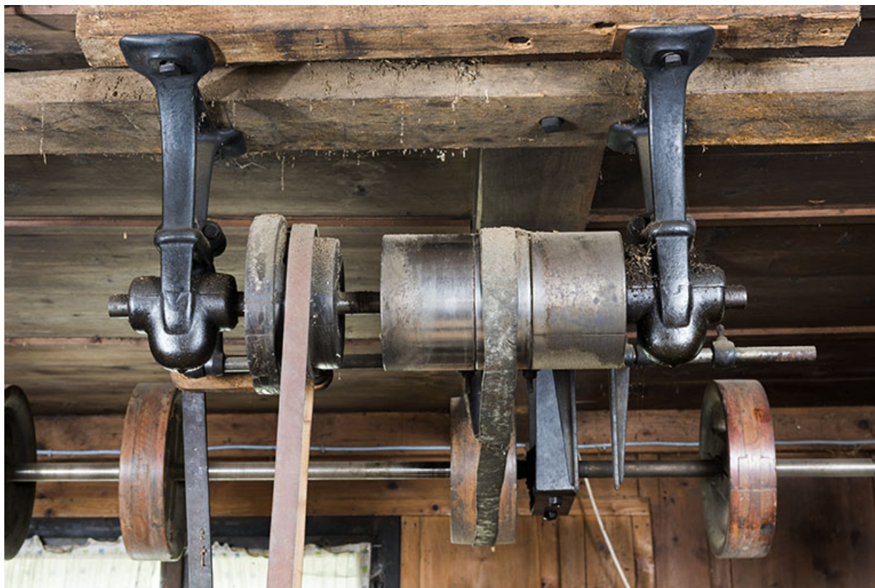
Système de transmission au plafond. 25, Les Gras
