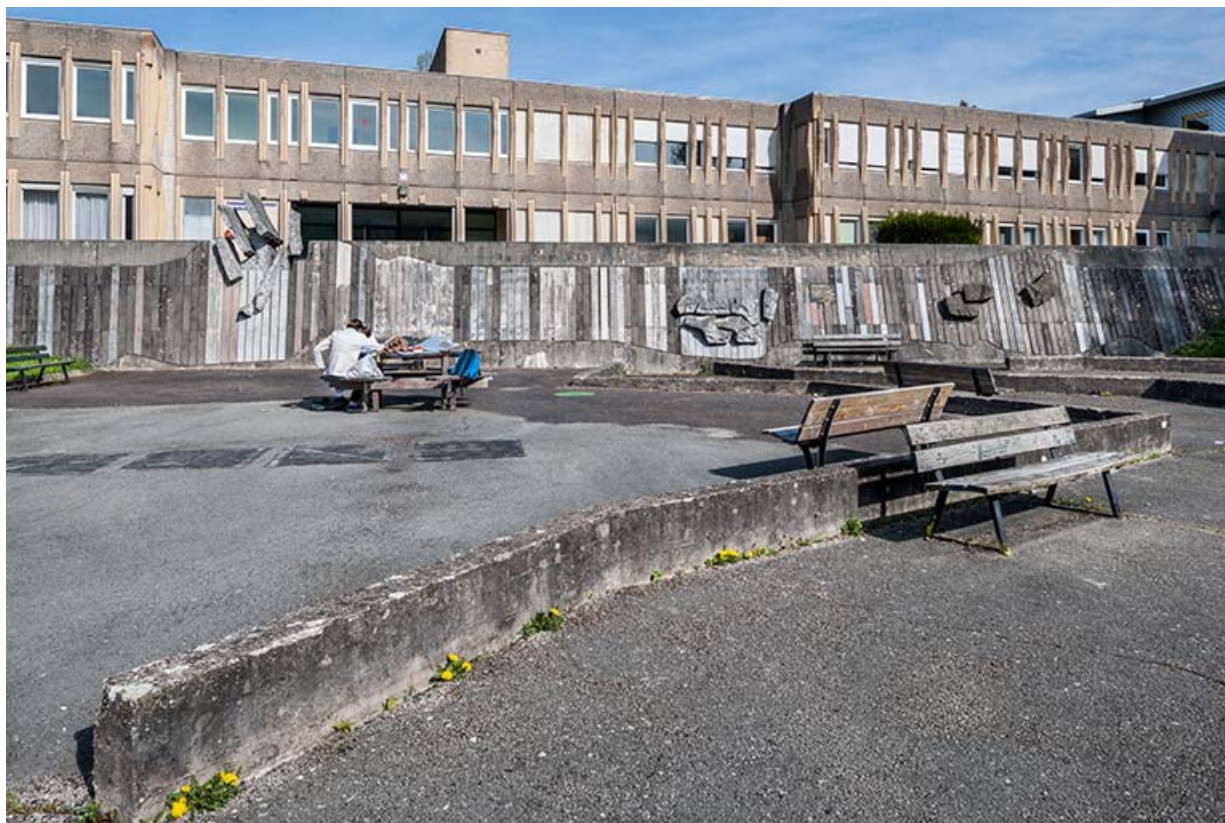
Vue partielle du mur au nord-ouest de la cour.
