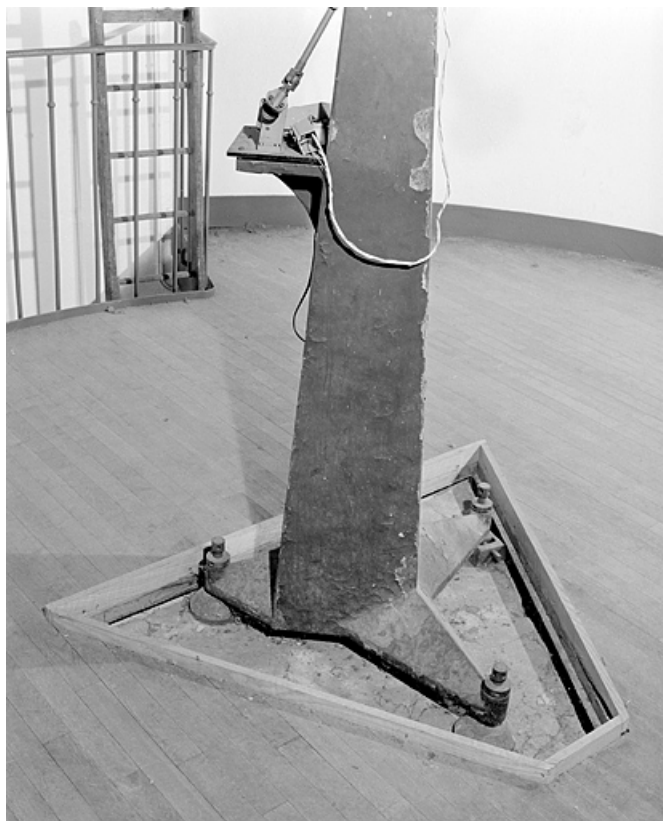
Pied et vis calantes. Le pied repose sur un pilier en béton, situé à l'étage inférieur.
