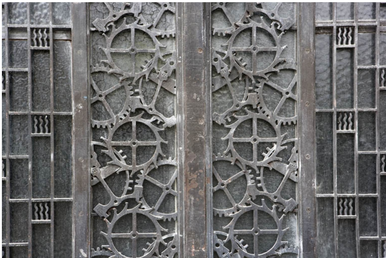
Porte centrale : motifs décoratifs à la jonction des vantaux (détail).
