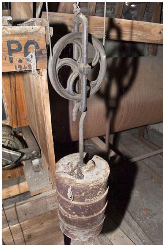
Un des poids actionnant les filins et l'une des inscriptions peintes sur la caisse. 25, Rougemont quartier de la Citadelle
