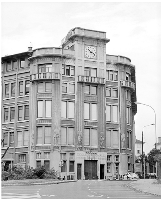
Vue d'ensemble du corps d'entrée et de l'horloge.
