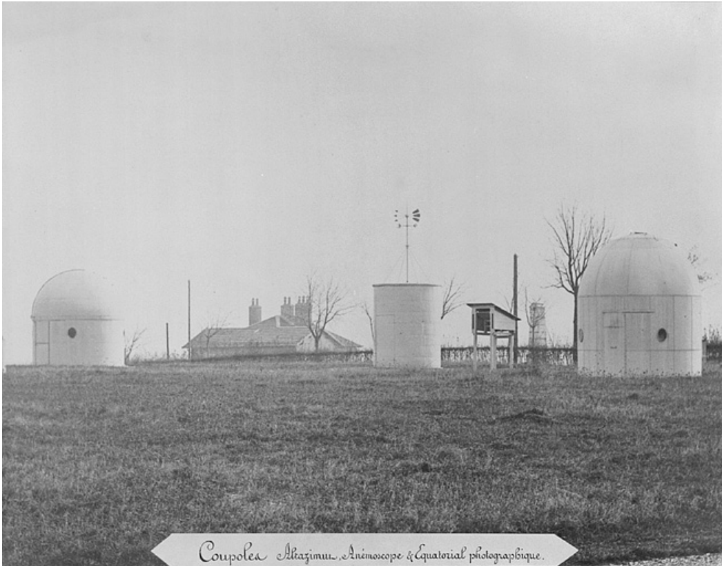
Coupoles. Altazimut, Anémoscope & Equatorial photographique [vues du nord-ouest], fin 19e siècle. 25, Besançon, 34, 36, 41 à 43 avenue de l' Observatoire, lieudit : la Bouloie
