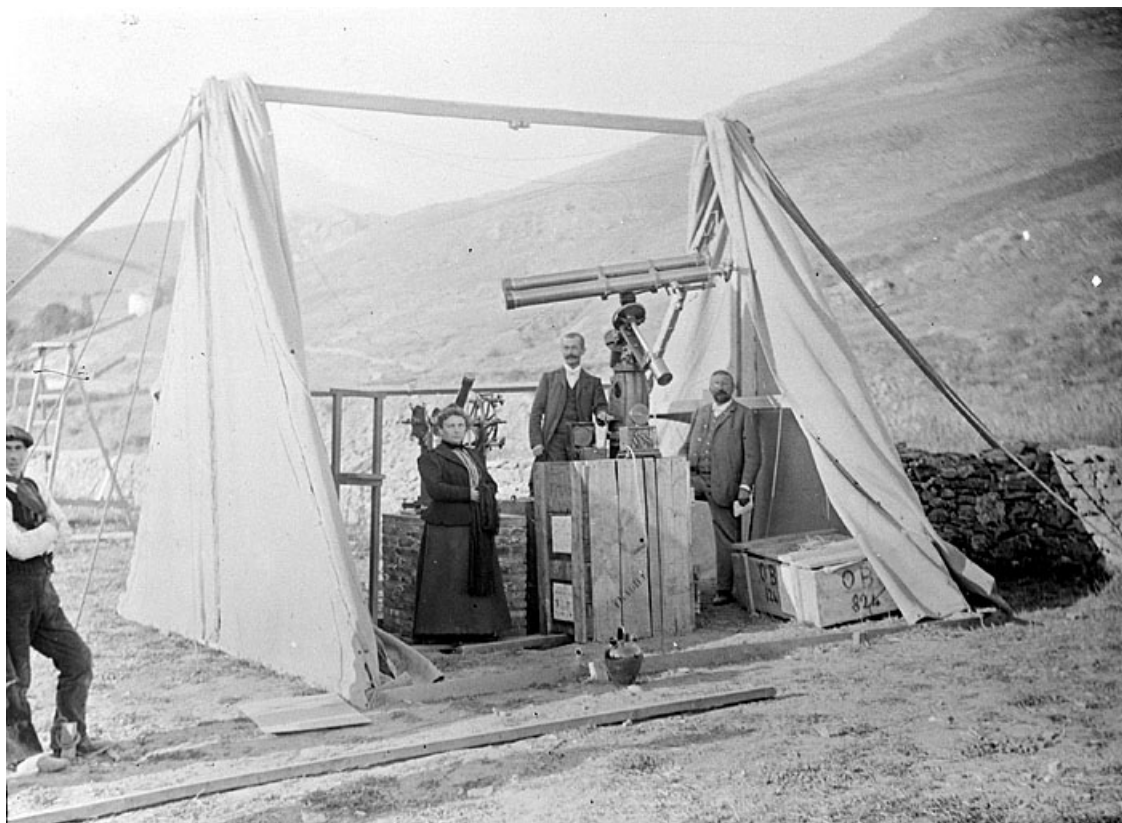
[Cistierna. Août 1905. Mission Hamy. Aurelio Garcia, M et Mme Leboeuf et M X posant à côté de la lunette photographique]. 25, Besançon, 34, 36, 41 à 43 avenue de l' Observatoire, lieudit : la Bouloie
