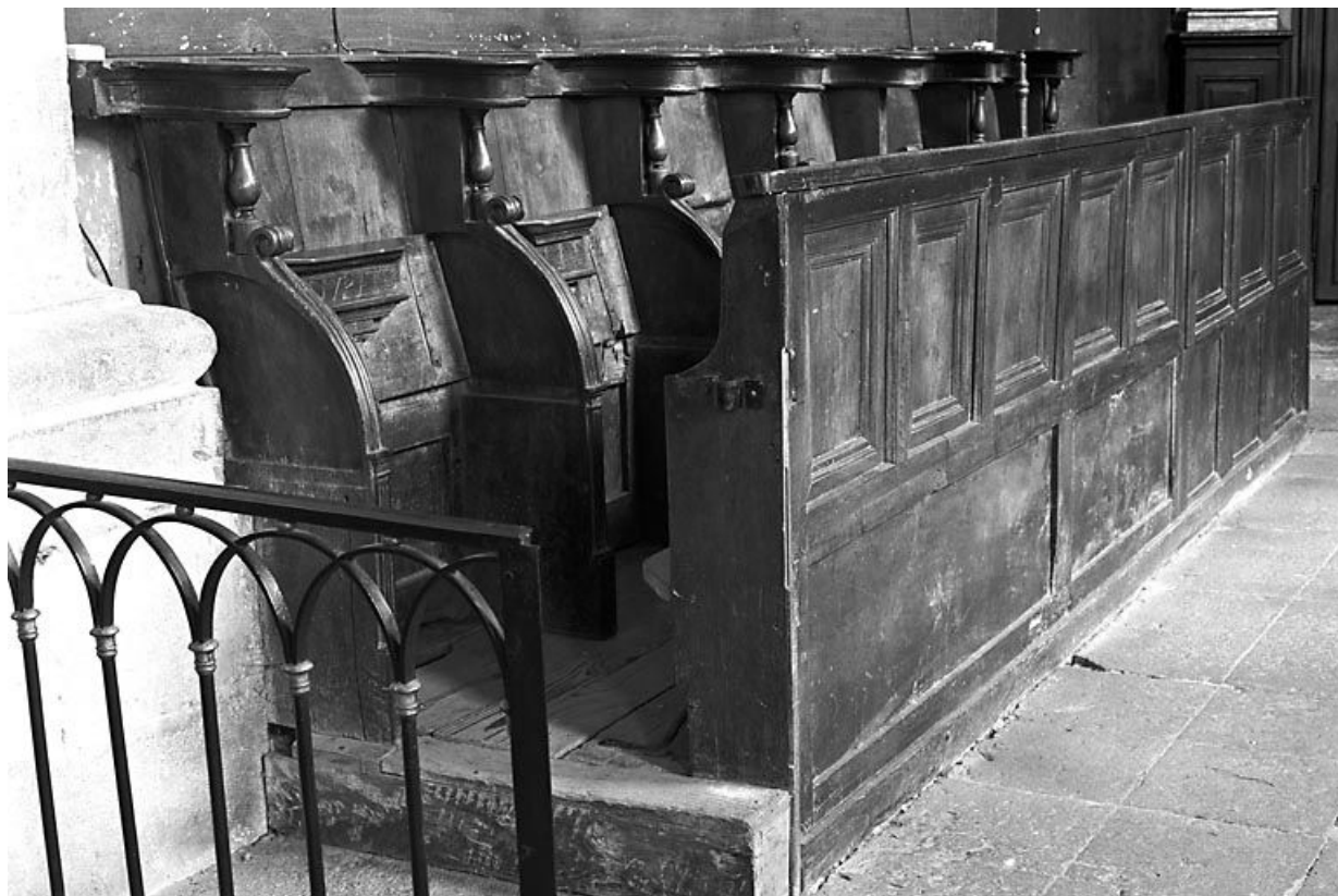
Vue d'ensemble du côté nord. 25, Lods
