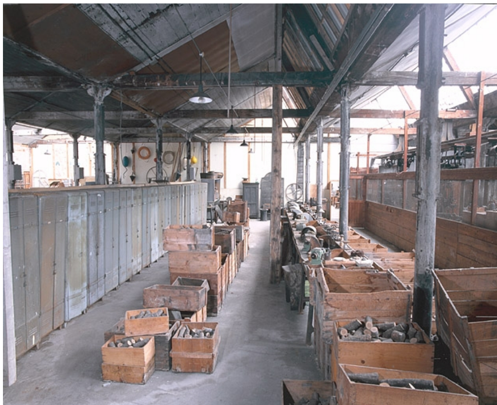
Vue de la partie de l'atelier principal transformée en vestiaires vers 1970.
