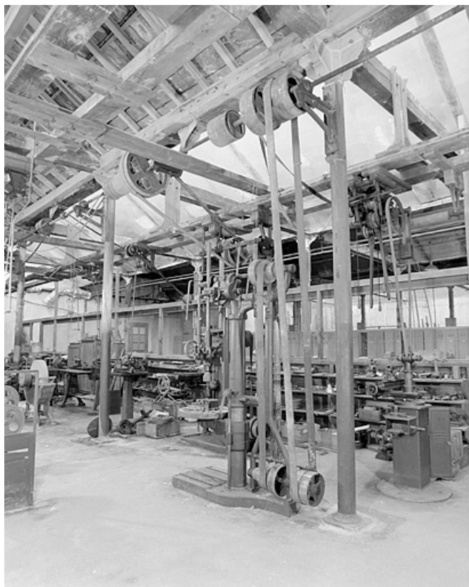
Atelier de mécanique. Transmission par courroies verticales de la perceuse à colonne.
