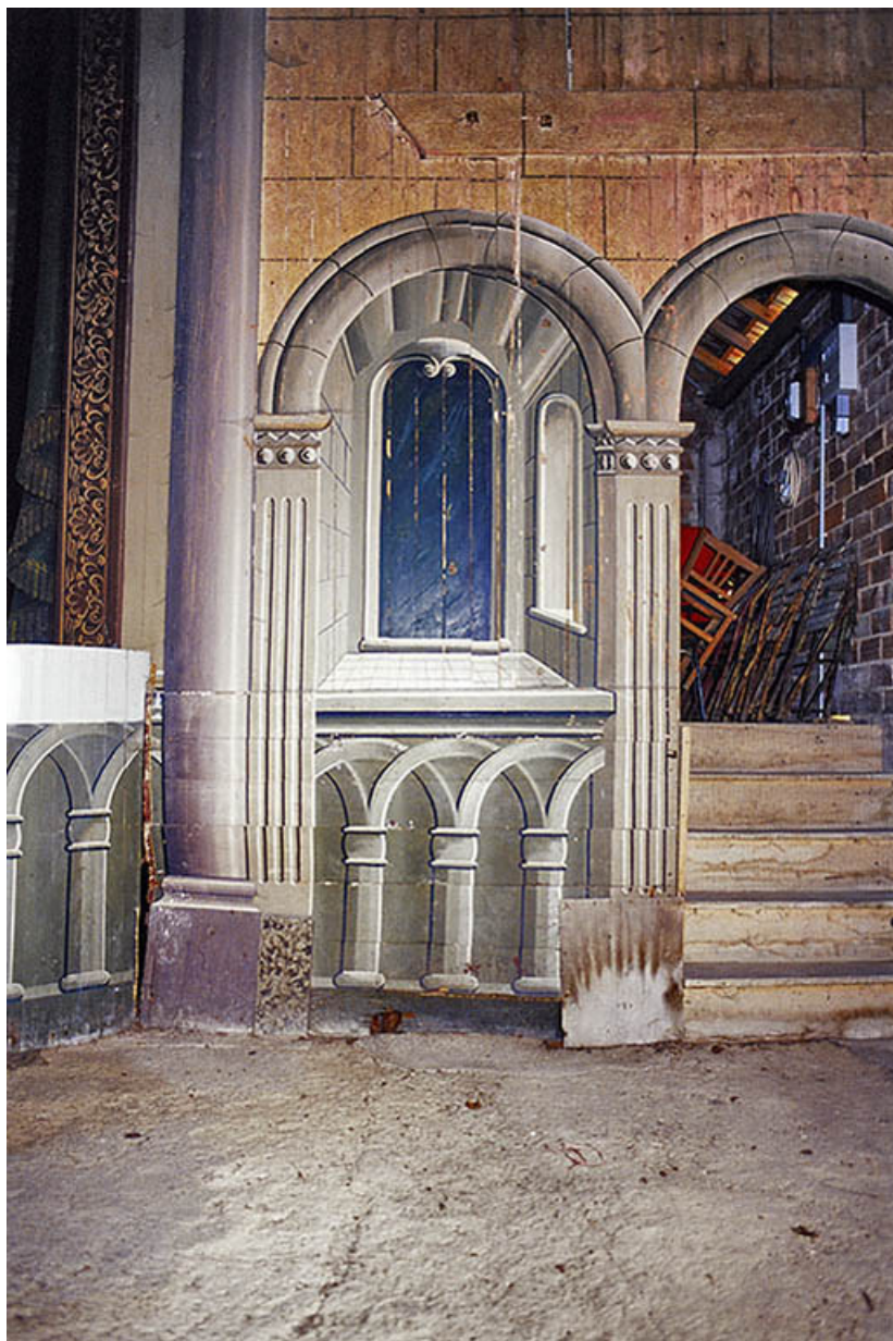
Fenêtre feinte côté cour, en 2002.
