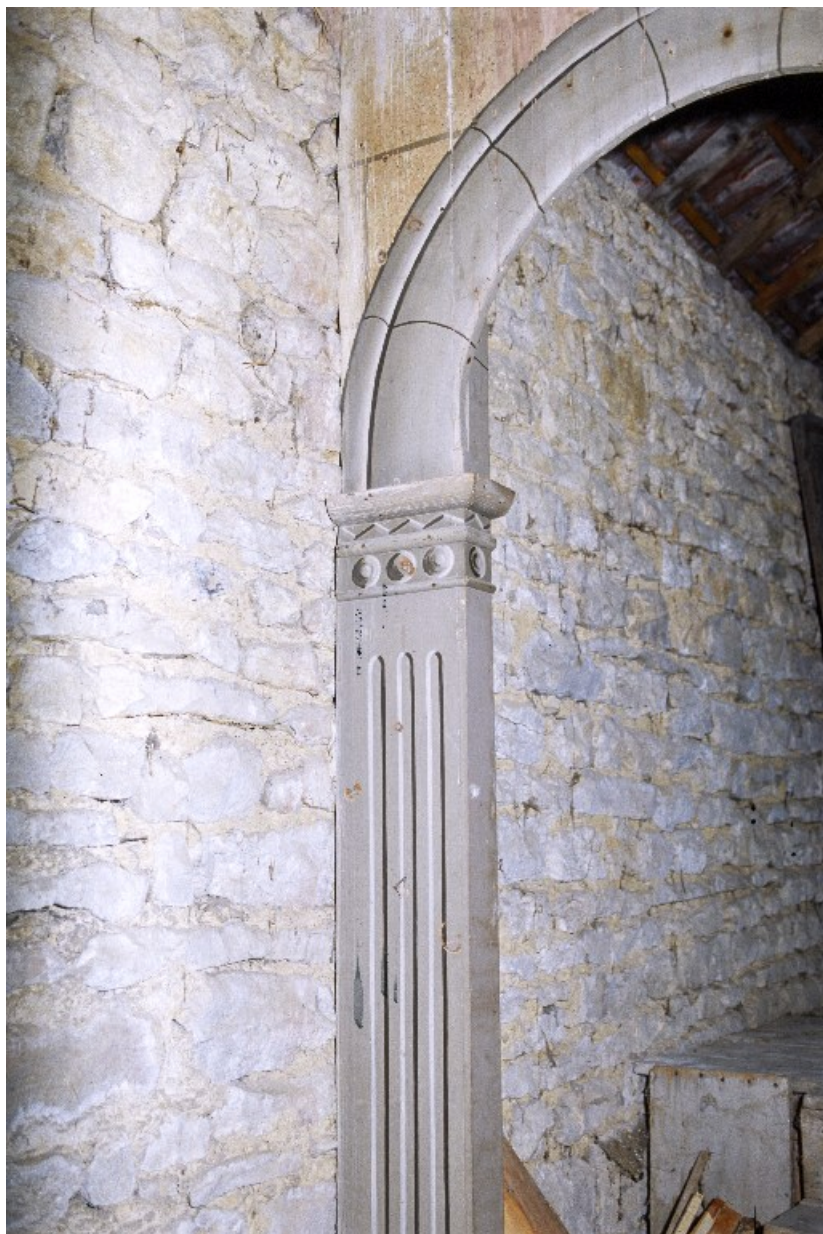
Baie côté jardin, en 2002 : détail du pilastre gauche.
