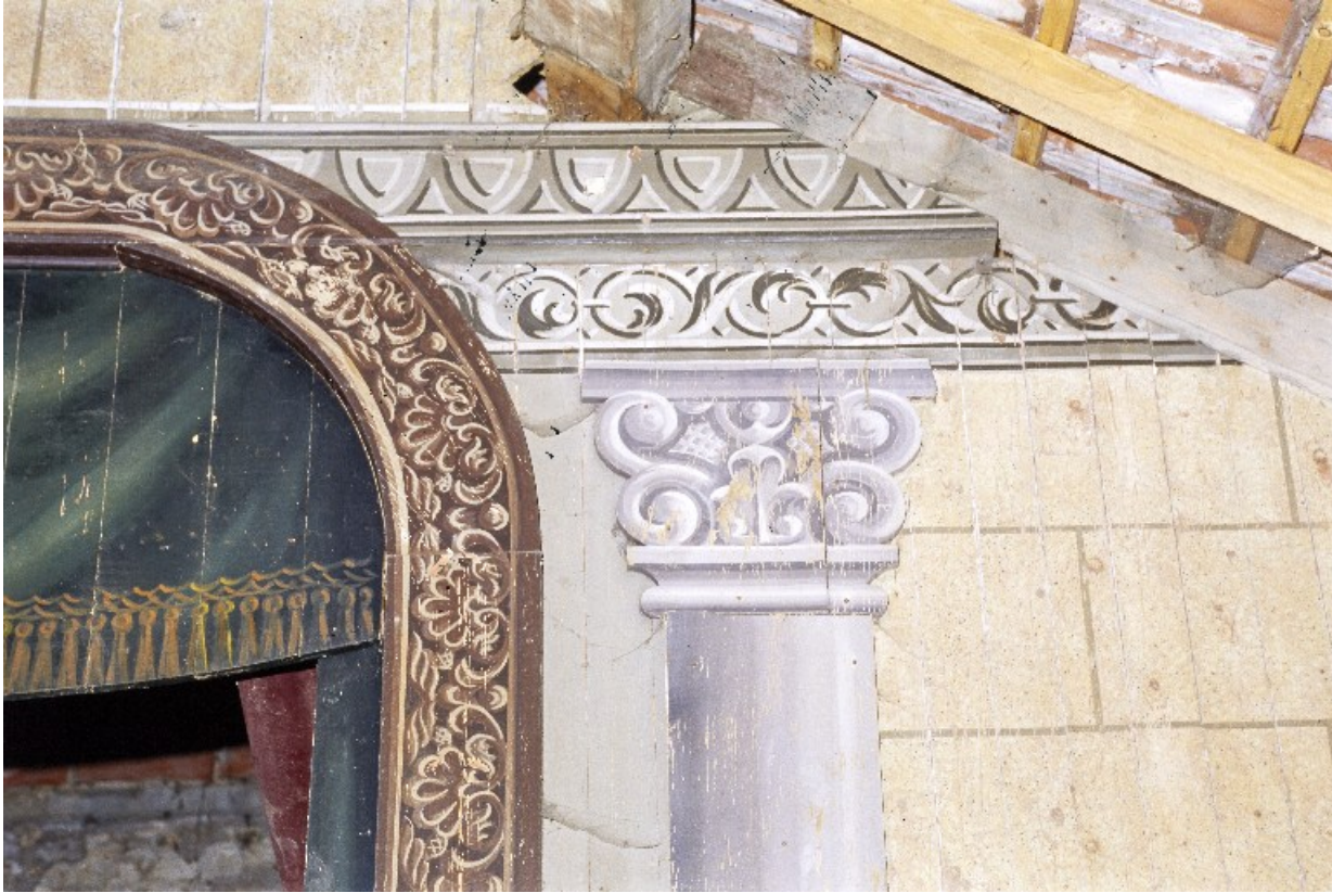
Cadre de scène, en 2002 : détail du chapiteau et du manteau d'arlequin côté cour (partie supérieure). 21, Alise-Sainte-Reine, 4 impasse du Théâtre
