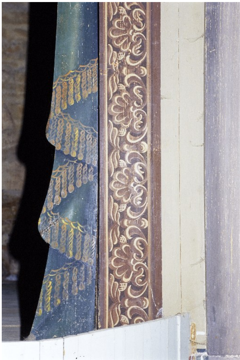
Cadre de scène, en 2002 : détail du manteau d'arlequin côté cour (partie inférieure), vue rapprochée. 21, Alise-Sainte-Reine, 4 impasse du Théâtre
