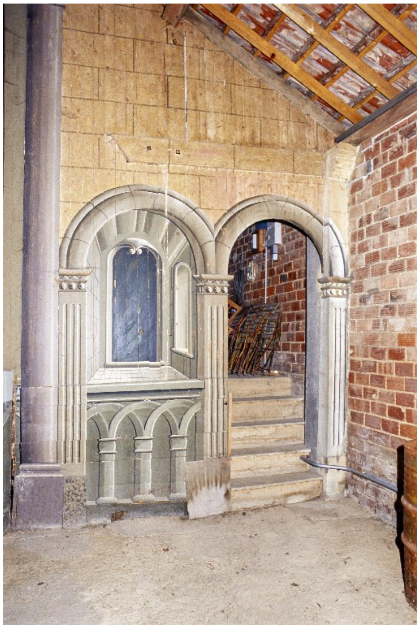
Baie côté cour, en 2002.
