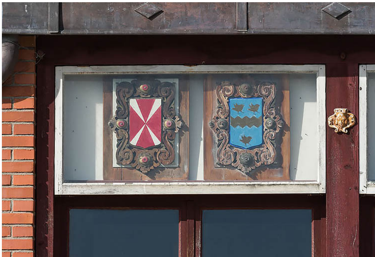
Communs (mur oriental du foyer) : deux armoiries (1er ensemble sur six en partant de la gauche).
