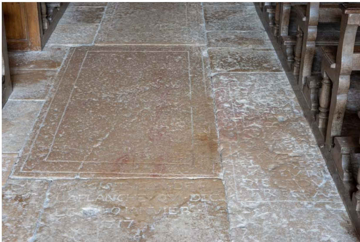
Dalle 3 : vue d'ensemble.
