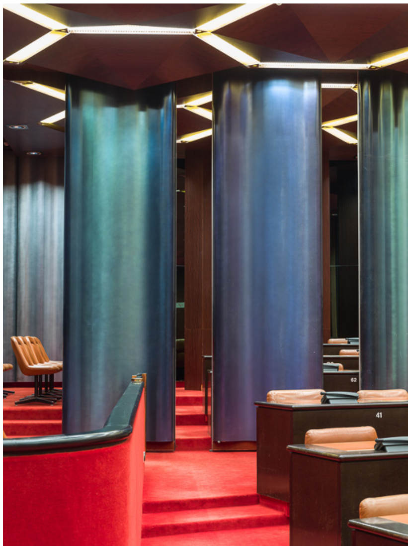
Salle des Assemblées : vue des panneaux de la cloison coulissante de séparation. 21, Dijon
