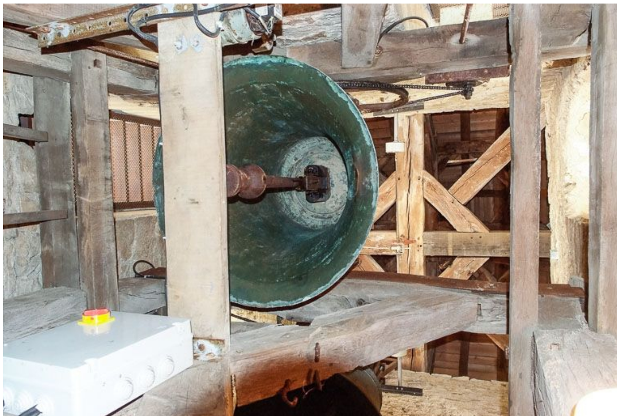
Vue depuis le plancher du clocher.
