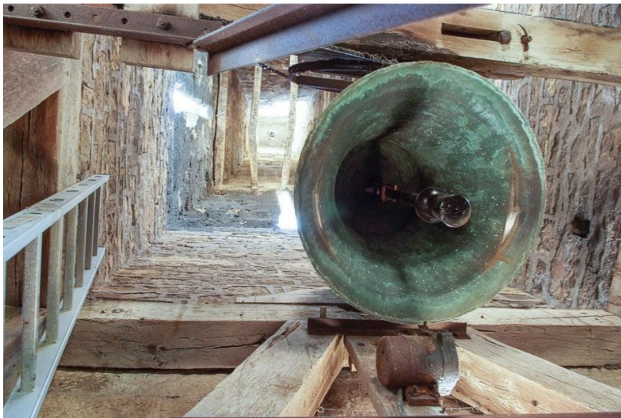
Vue depuis le plancher du beffroi.
