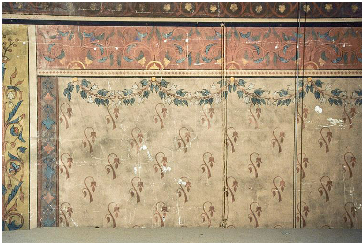
Nef, mur nord (1991) : peinture monumentale.
