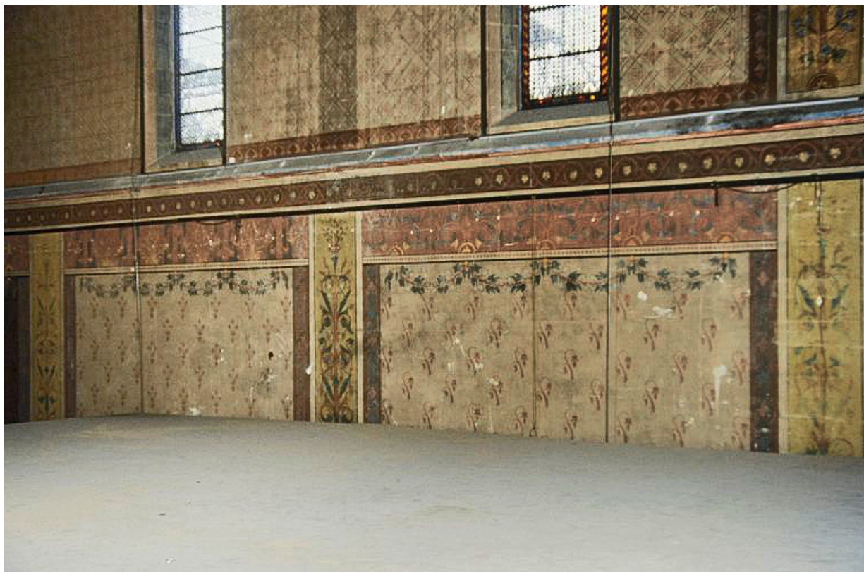
Nef, mur sud (1991) : peinture monumentale.
