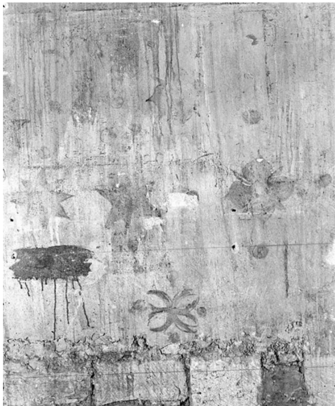
Choeur, mur sud : traces de décor.
