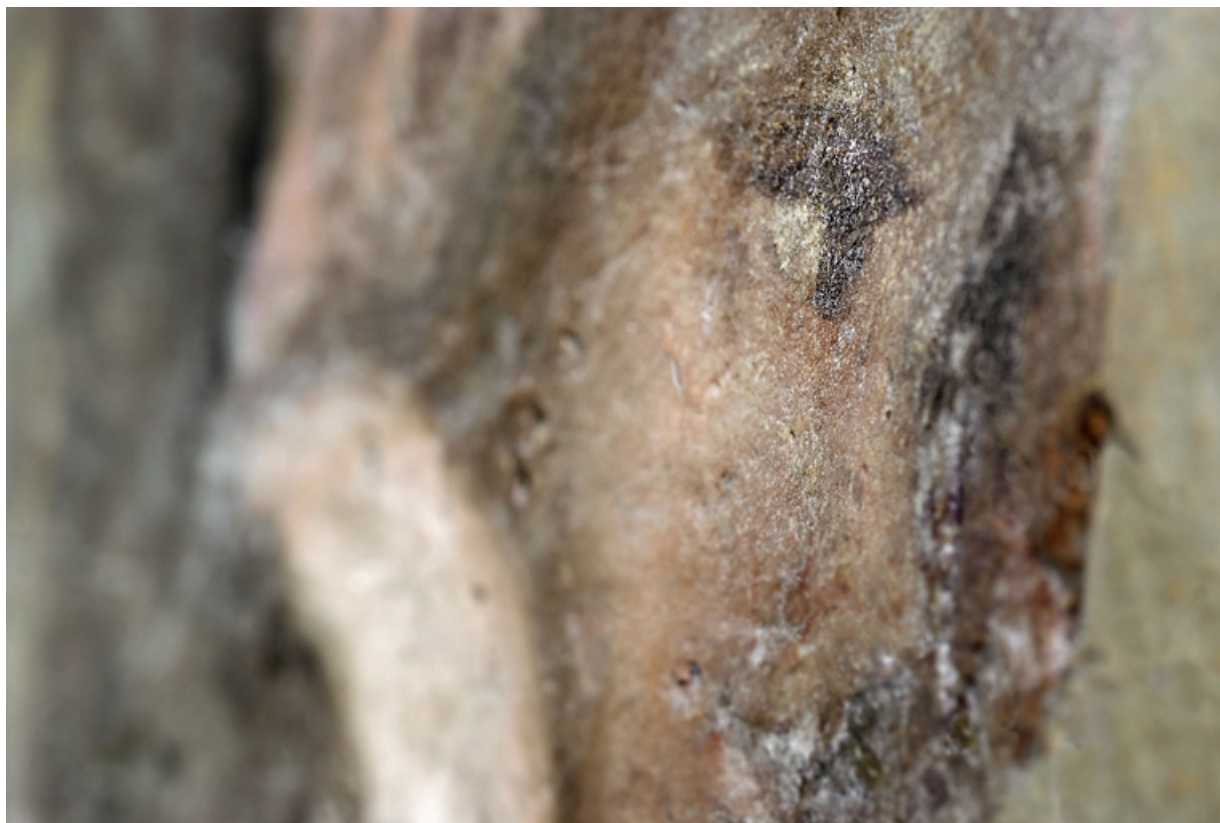
Peinture de l'embrasure de la porte : détail. 21, Châteauneuf château fort
