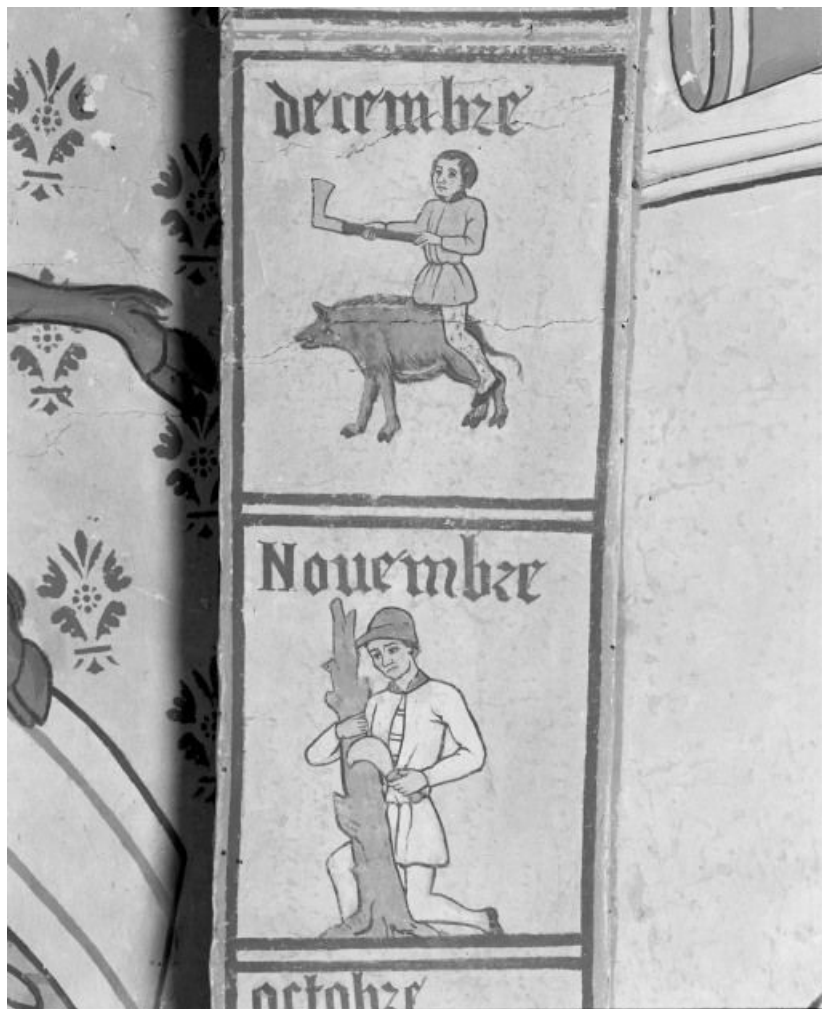
Choeur, arc doubleau, les travaux des mois: novembre et décembre 21, Bagnot
