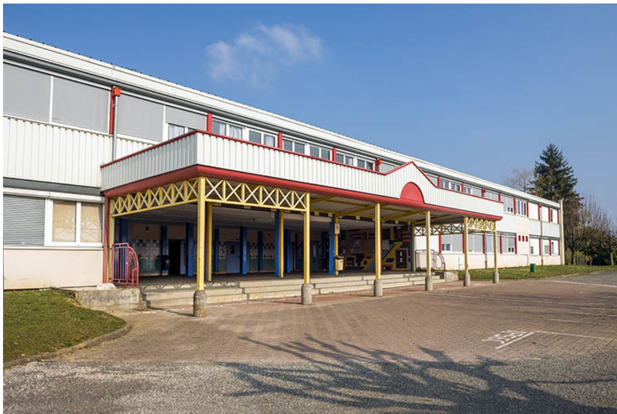
L'auvent et le préau de l'externat nord sur cour.
