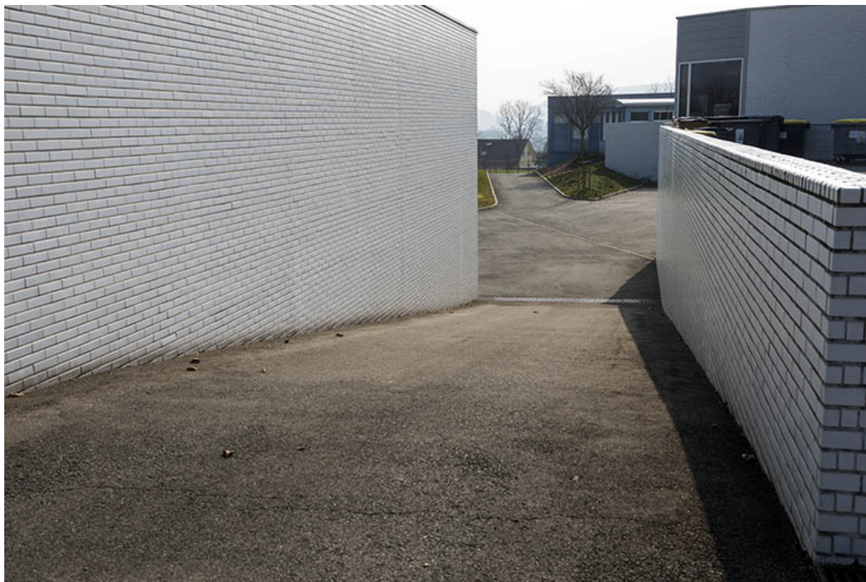
Circulation extérieure à l'ouest de la chaufferie, à l'est de la restauration.
