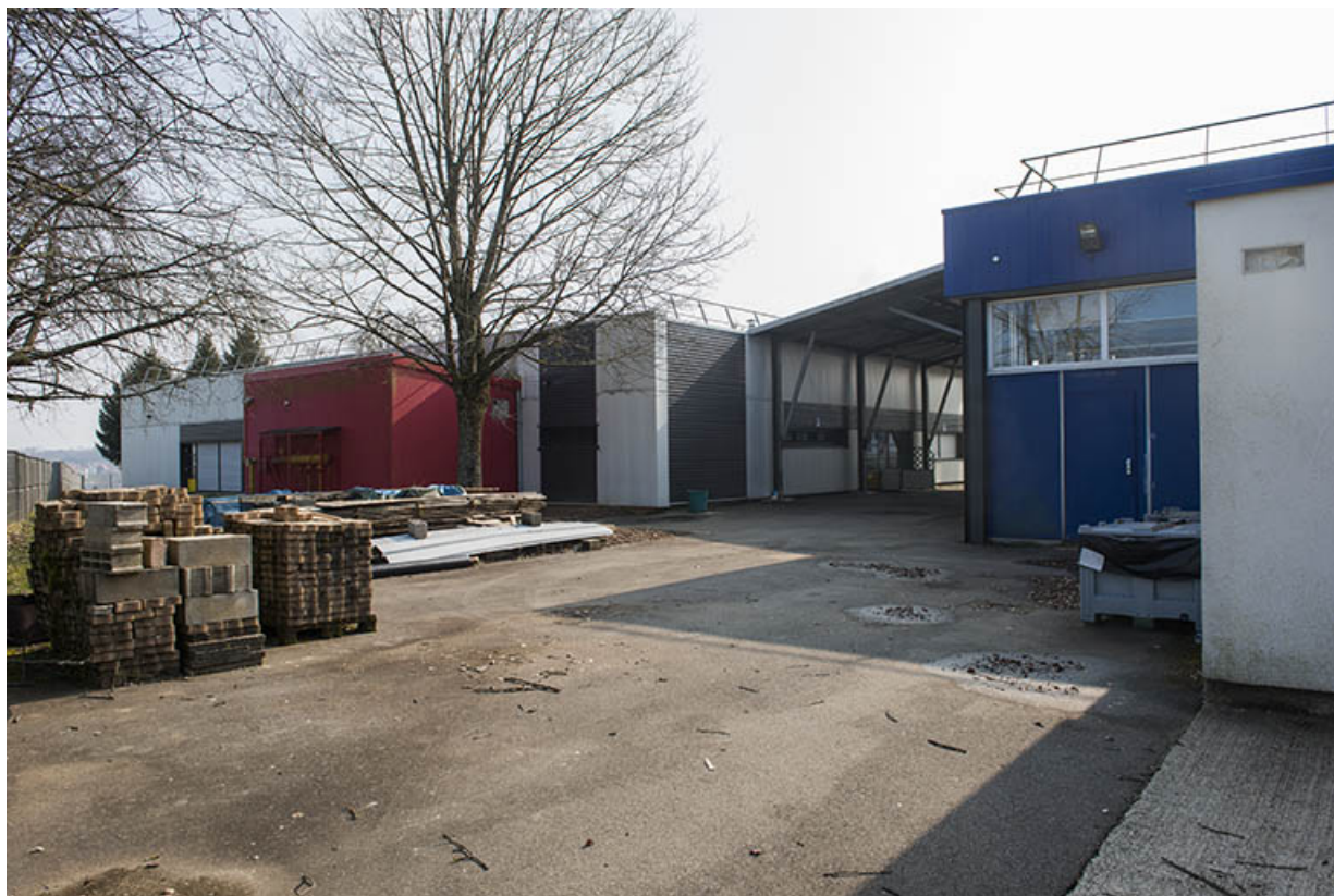
Passage couvert entre les ateliers est et ouest, vu du nord.
