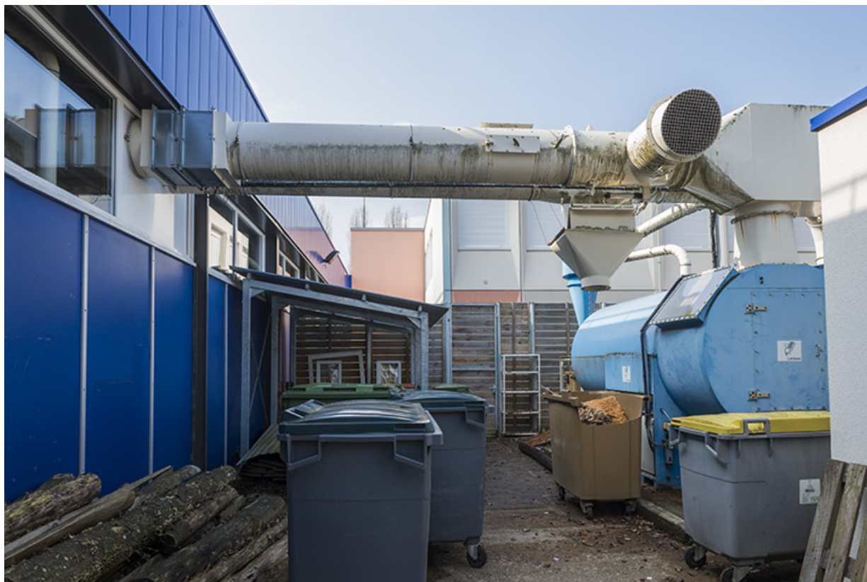
Traitement des déchets bois au nord de l'atelier bois.
