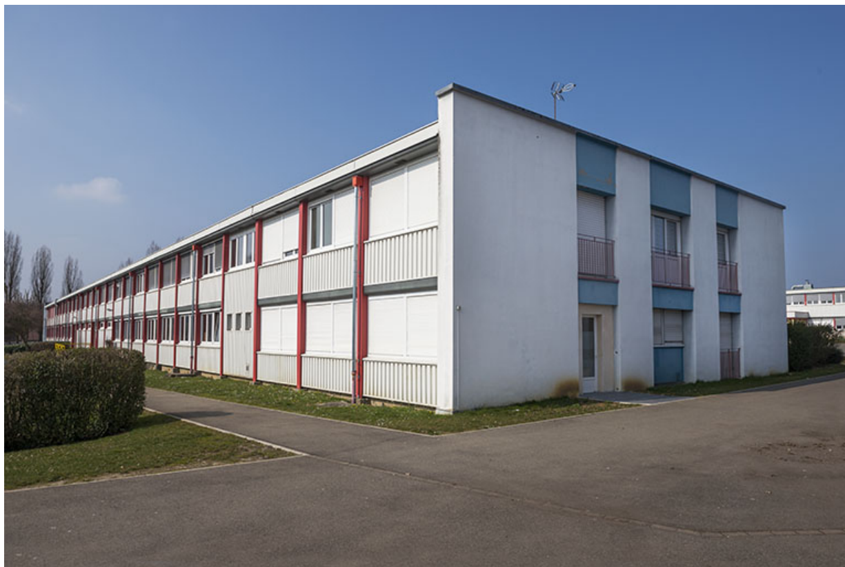
Pignon est de l'externat sud et sa façade sud.
