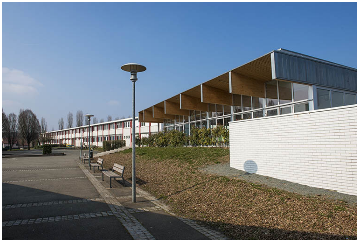
Façade sud de la cantine et de l'externat sud.
