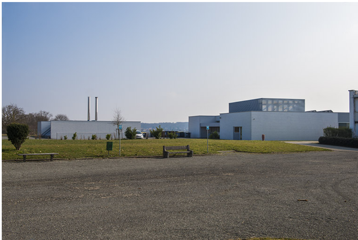
Vue d'ensemble des constructions de Catherine Dormoy : chaufferie et restauration.
