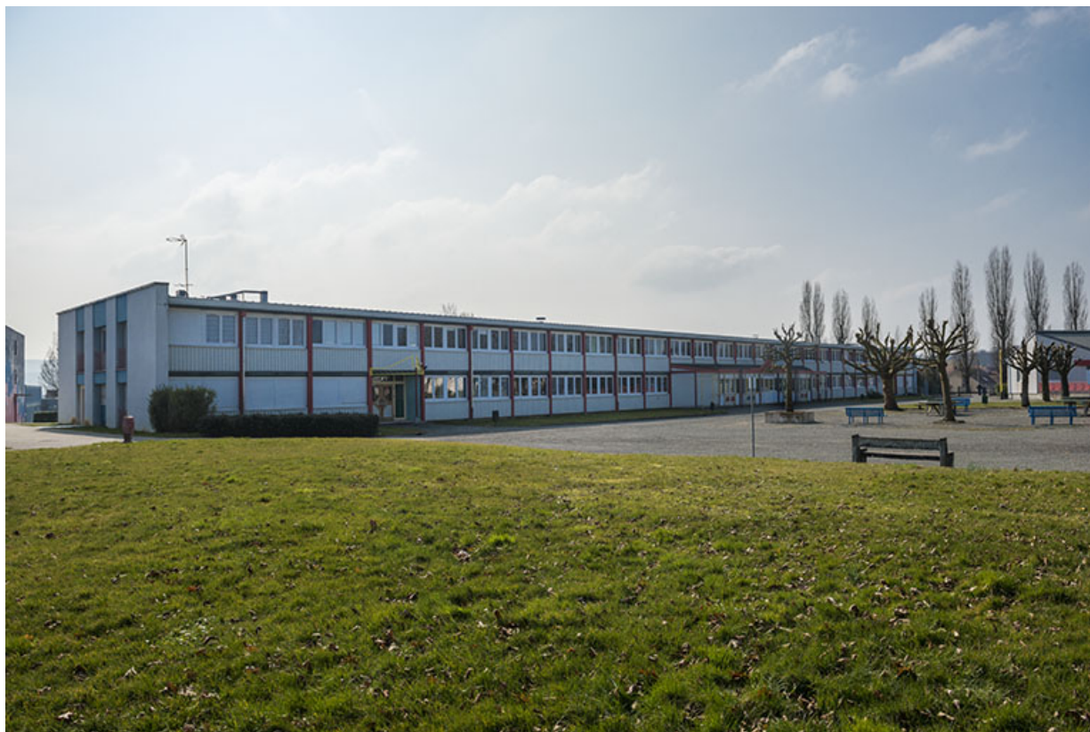
Façade antérieure nord sur cour de l'externat sud.
