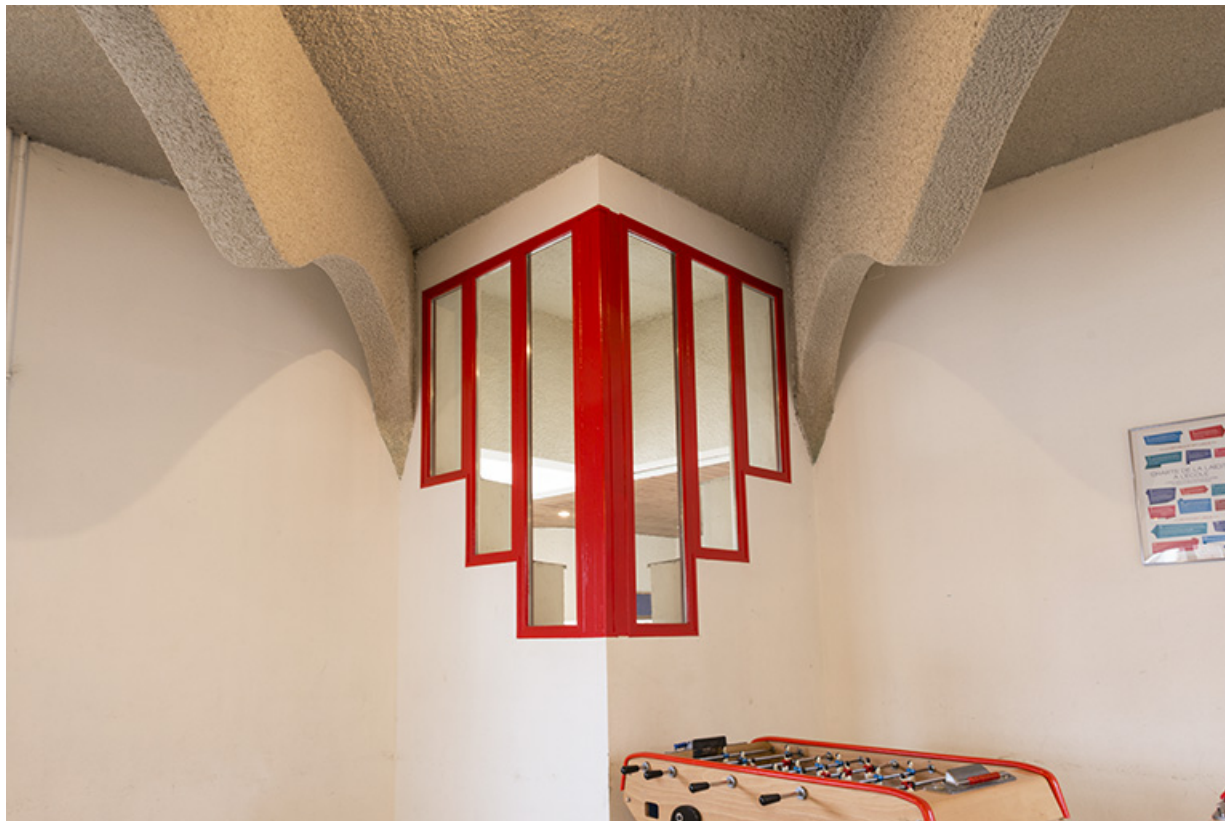
Détail de vue intérieure du foyer.
