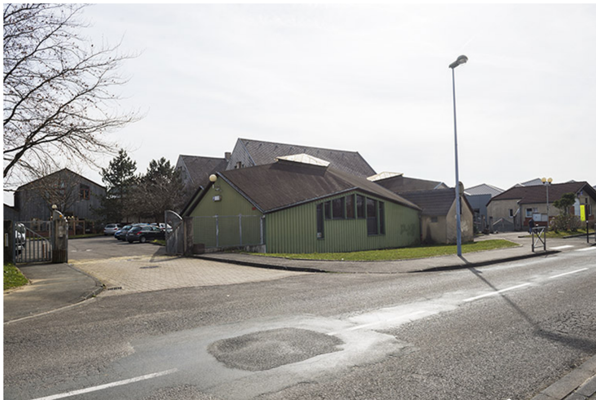
Vue des façades nord des ateliers depuis l'entrée nord-est de la rue d'Alembert.
