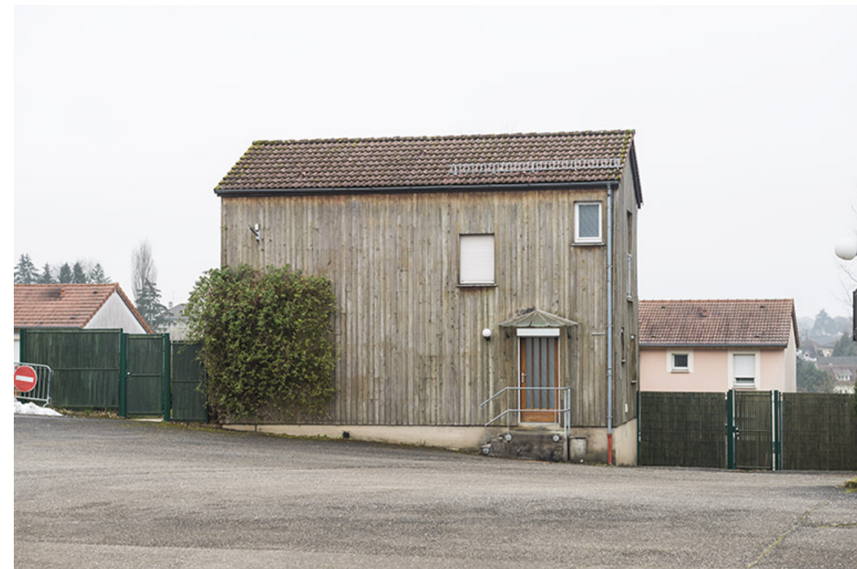
Vue de face de la façade antérieure du logement au sud de la cour.
