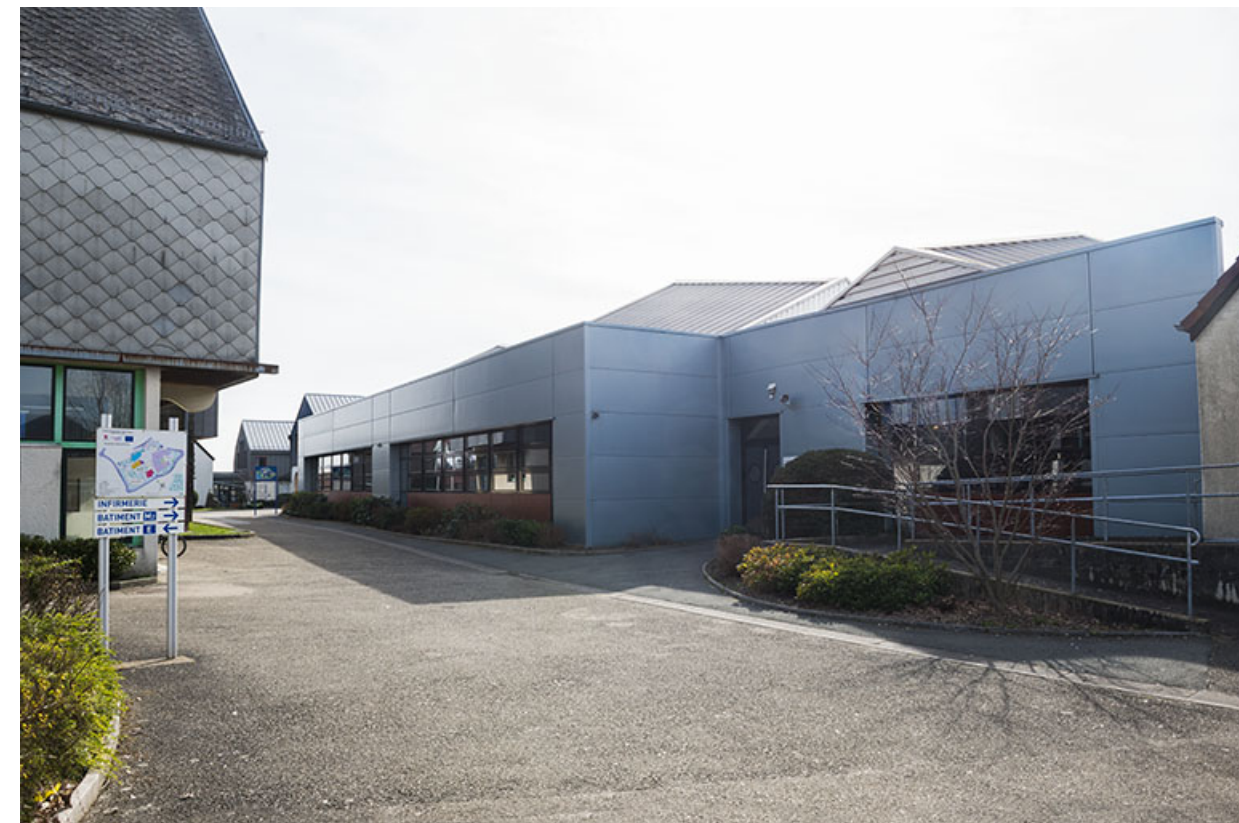
Façade est des ateliers mécaniques vue depuis le nord.
