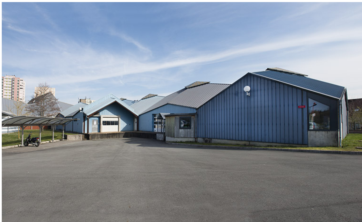
Façades postérieures ouest des ateliers de mécanique.
