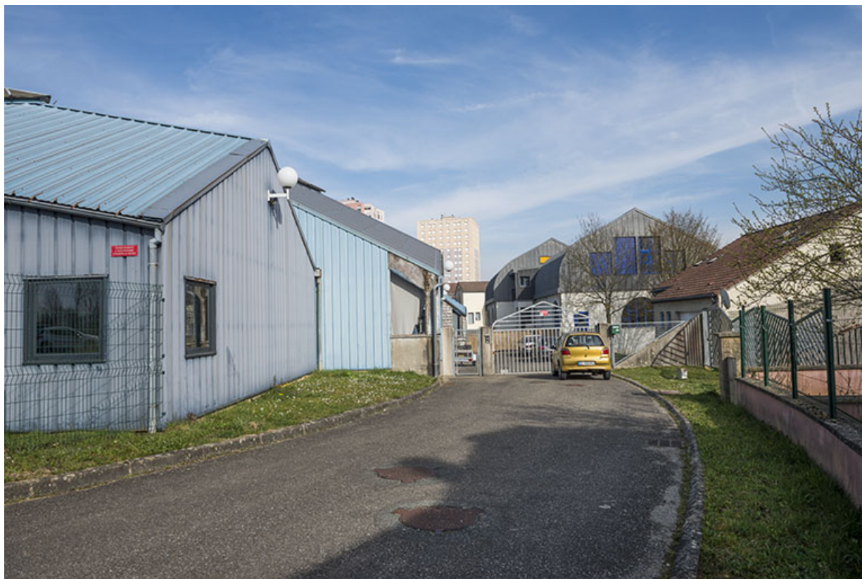
Vue de l'ouest, l'entrée sud-ouest, entre les ateliers et le logement de fonction.
