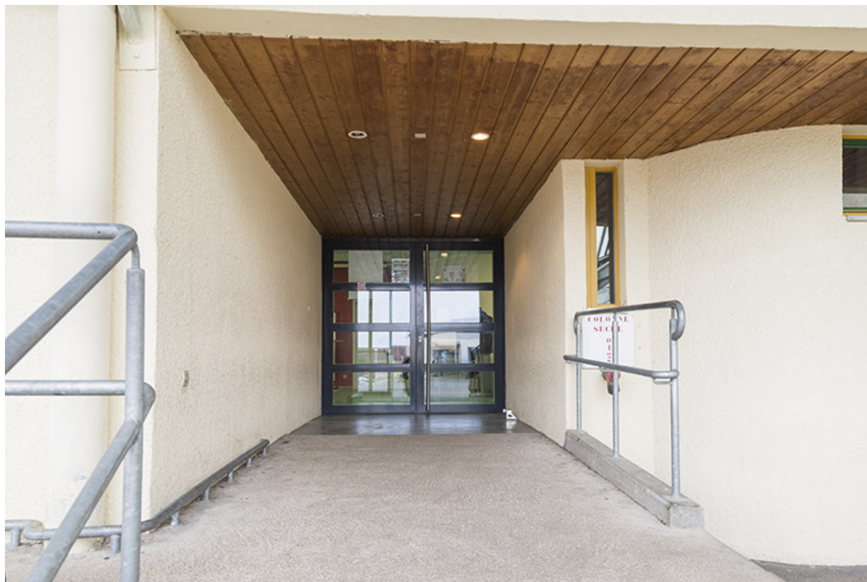
Détail de l'entrée du bâtiment abritant la vie scolaire.
