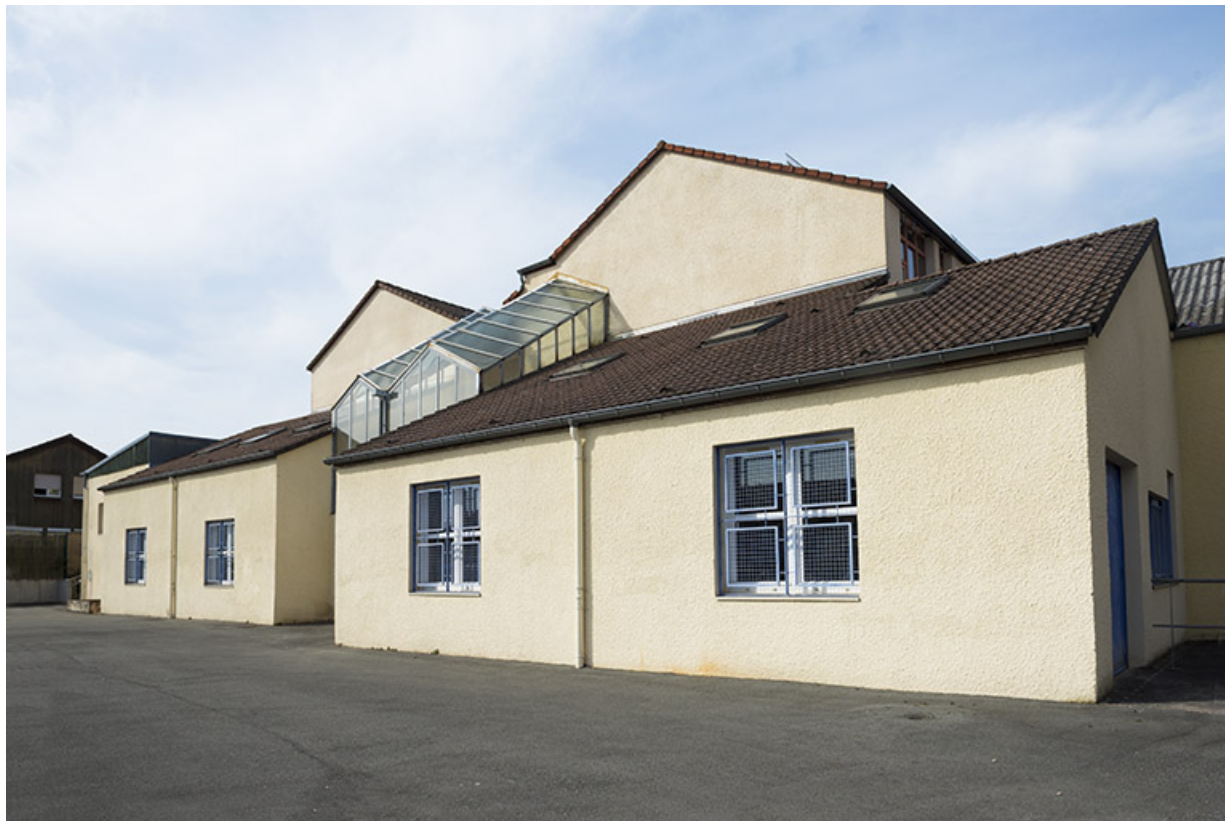
Façade sud de l'externat sud-est bordant la rue du bocage.
