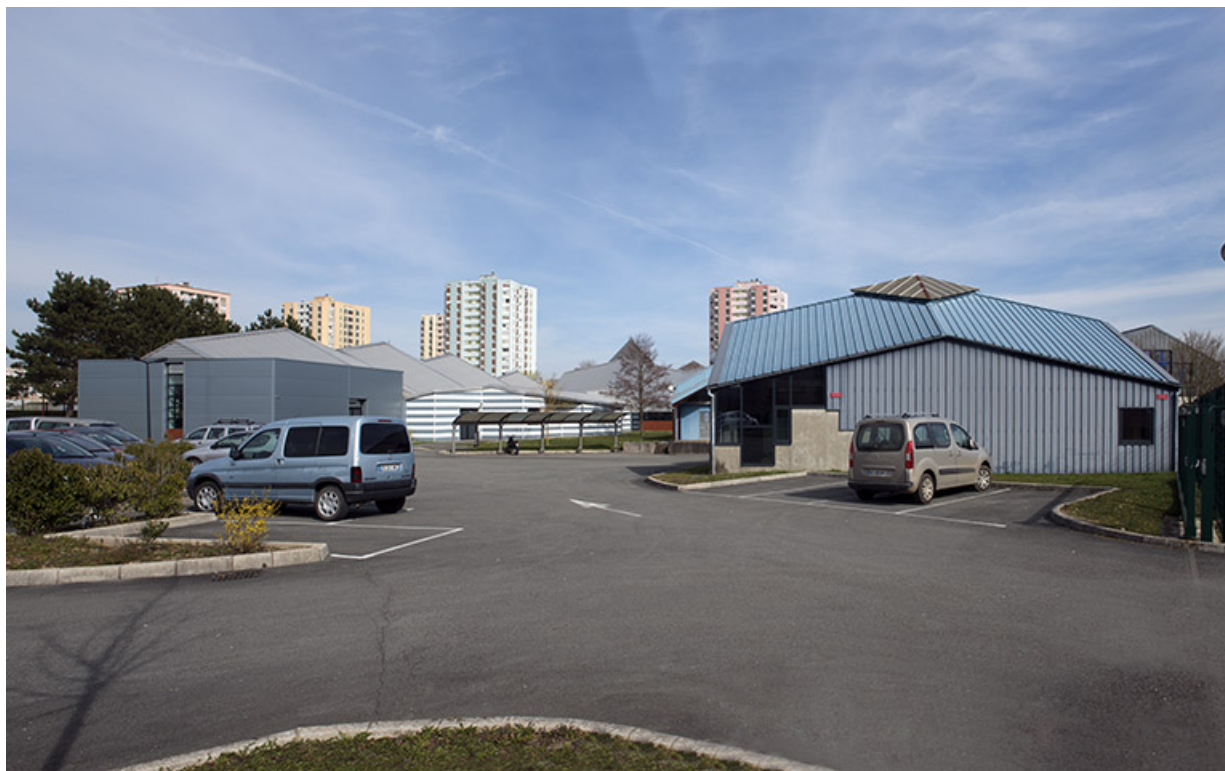
Aire de stationnement ouest et façades postérieures ouest des ateliers de mécanique.
