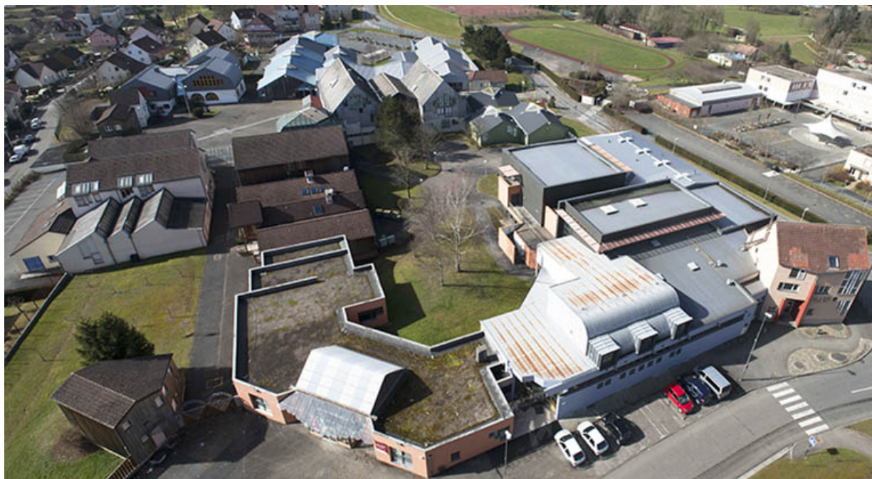
Vue d'ensemble depuis un étage supérieur de l'immeuble d'en face.
