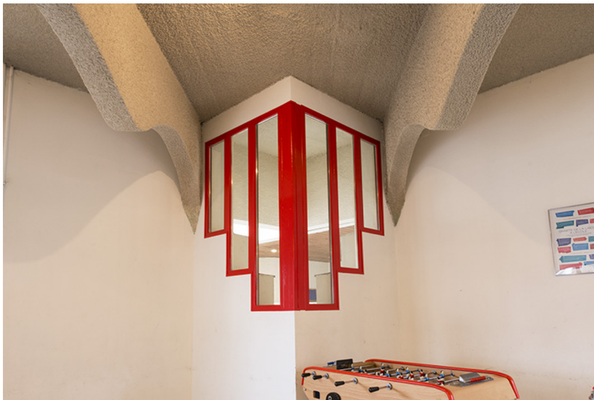
Détail de vue intérieure du foyer.
