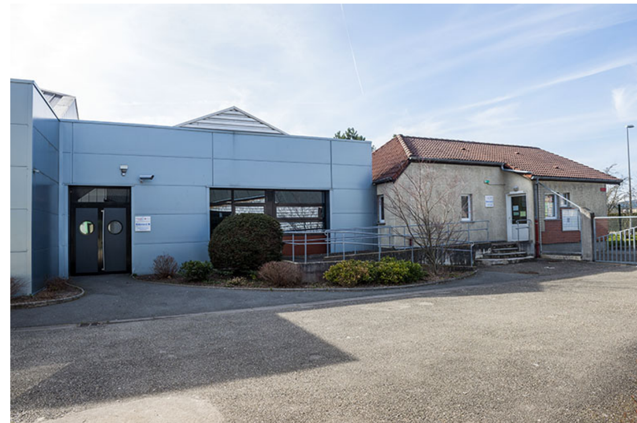
Façade est de l'atelier et angle nord-est de l'infirmerie, à l'entrée nord-ouest de la rue d'Alembert. 90, Bavilliers rue d' Alembert
