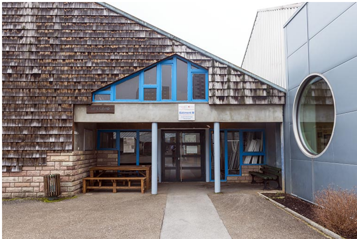
Bavilliers, lycée Denis Diderot : entrée de l'atelier messidor.
